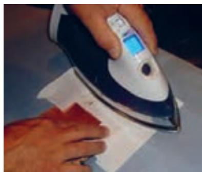
شکل ۹-۷- کشیدن اتو روی کاغذ و فیبر
