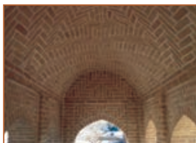
ب - استفاده از آجر برای سقف قوسی
