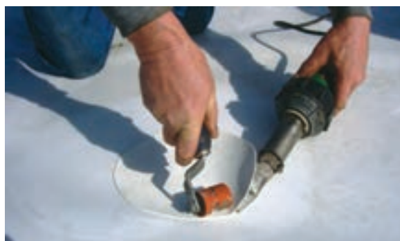
شکل ۱۲- جوشکاری با گاز داغ به صورت دستی
