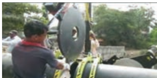
شکل ۱۹- جوشکاری لب به لب Butt Fusion
