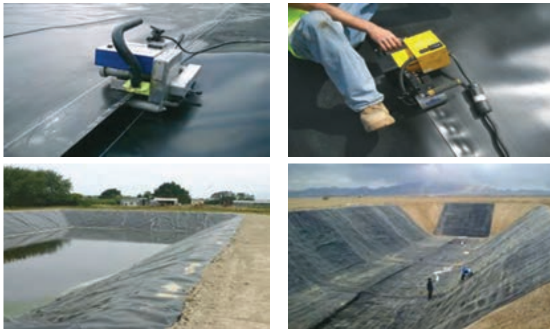
شکل ۱۵- جوشکاری عایق‌های پلاستیکی (ژئوممبران) استخرهای ذخیره آب
