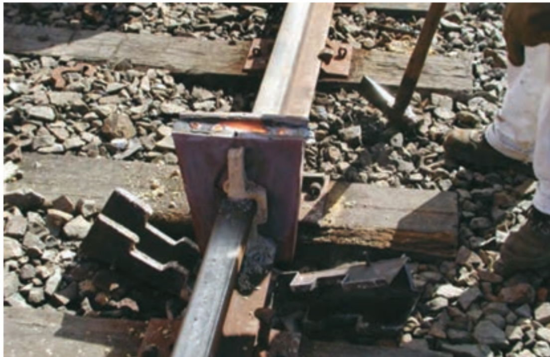
شکل ۲۶- باز کردن گیره و حفاظ قالب
