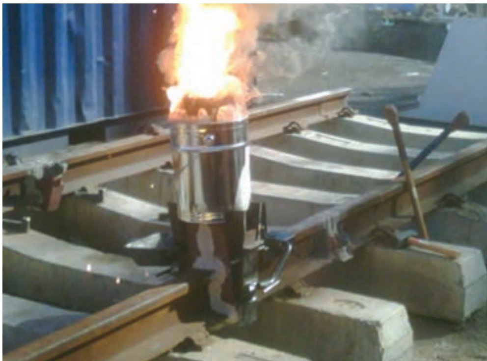
شکل ۲۴- نمایی از انجام واکنش ترمیت
