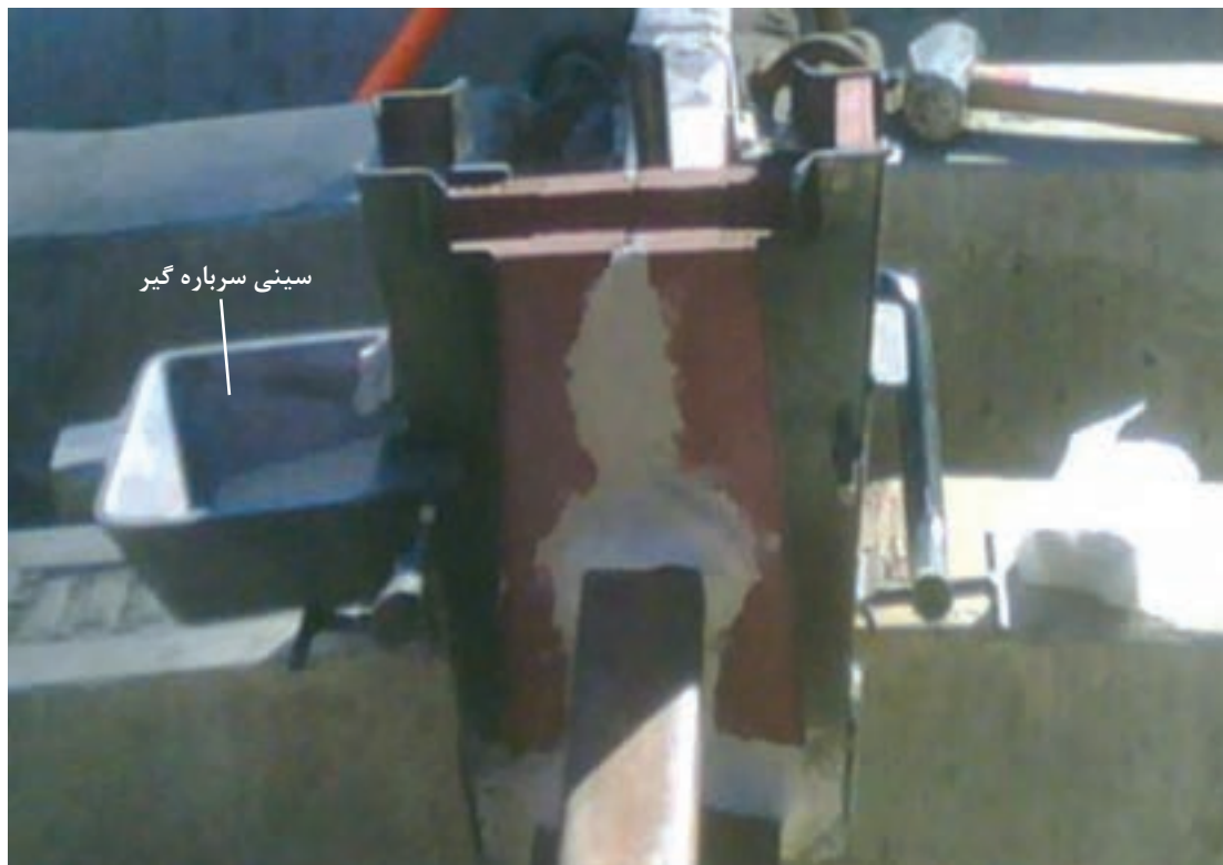
شکل ۲۰- نصب سینی‌های سرباره گیر
