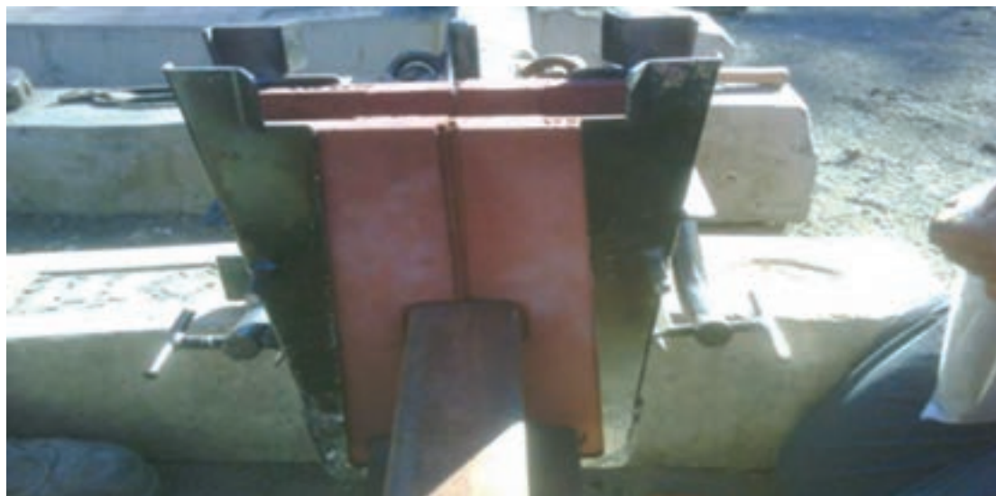
شکل ۱۸- نصب قالب اطراف ناحیه اتصال
