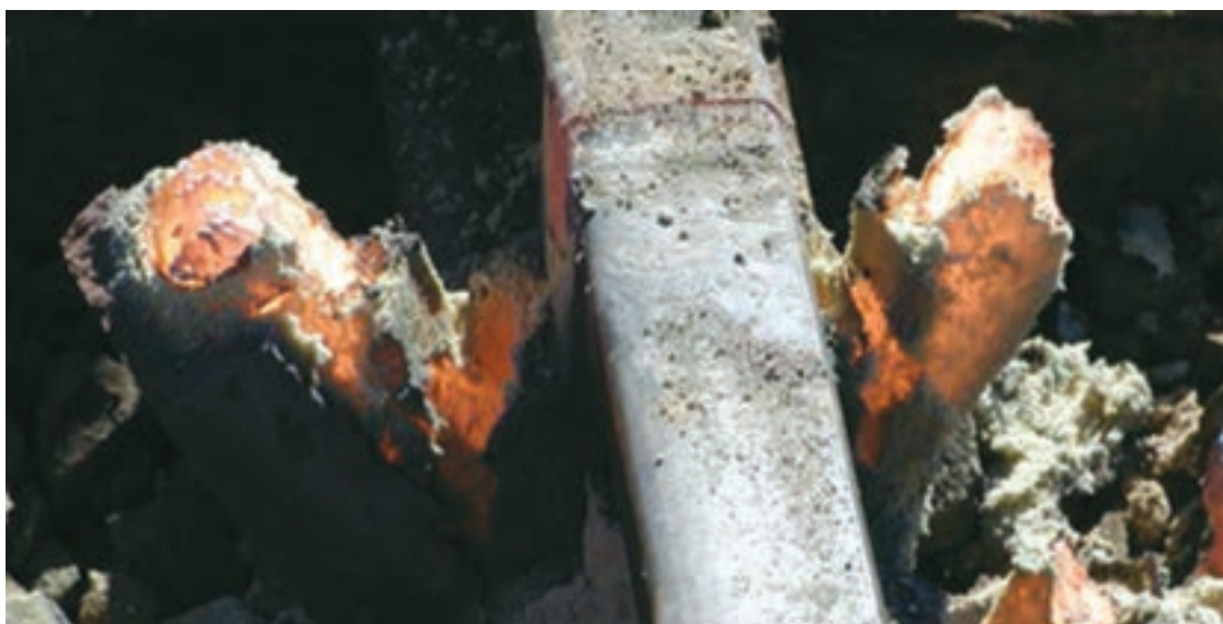
شکل ۲۸- برش گرده اضافی جوش
