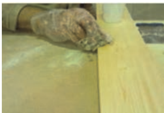
شکل ۶۶- زدن آب قبل از بتونه کاری
