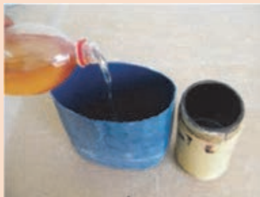
شکل ۷- رقیق کردن آستری قیری با بنزین
