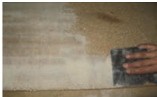
شکل ۶۷- بتونه کاری پوششی
