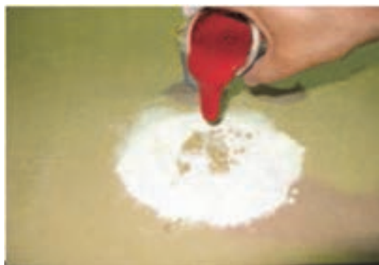
شکل ۷۹- اضافه نمودن روغن الیف به بتونه روغنی
