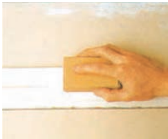
شکل ۱۲- سنباده کاری در جهت الیاف
