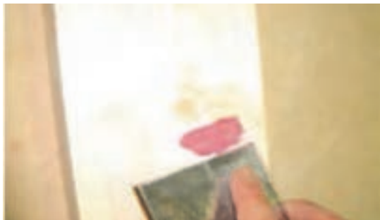
شکل ۹۳- لکه گیری قبل از ماستیک کاری
