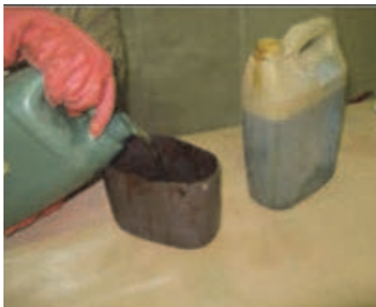
شکل ۴- رقیق کردن روغن الیف با تینر روغنی
