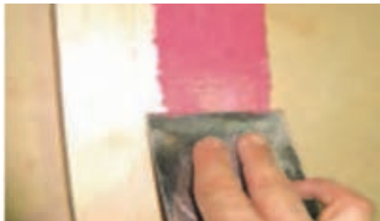
شکل ۹۲- ماستیک کاری با بتونه روغن رنگ قرمز
