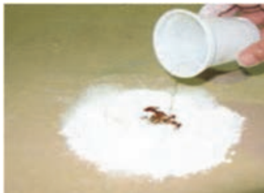
شکل ۷۸- اضافه نمودن آب به بتونه روغنی
