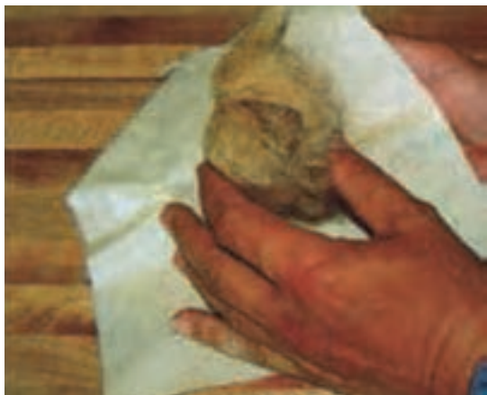
شکل ۱۴۶- زدن سیلر با کهنه رنگ‌کاری
