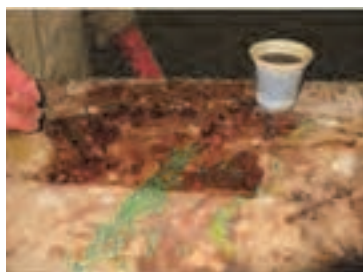
شکل ۵۹- زدن روغن بزرک با کهنه
