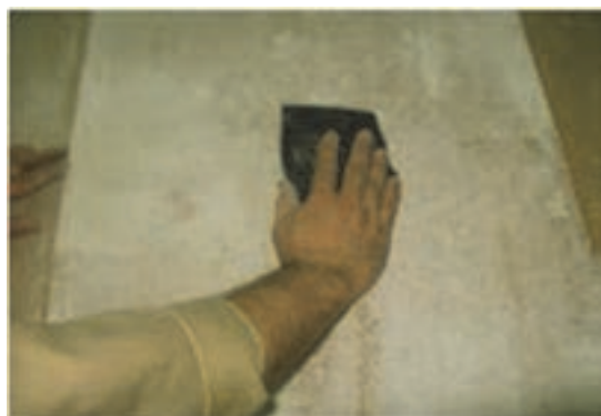
شکل ۸۰- سنباده‌کاری روی سطح بتونه سریشی
