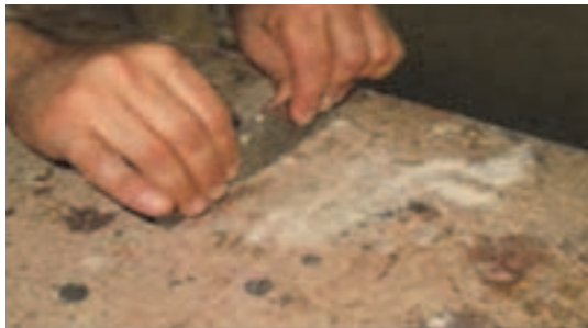
شکل ۱- استفاده از لیسه برای برداشتن مواد اضافی
