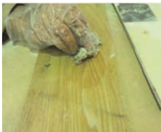
شکل ۱۰- آستری روی یک تخته نراد با کهنه رنگ کاری
