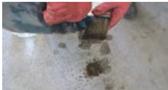
شکل ۳- شستن قلم‌مو با حلال به روش ناصحیح
