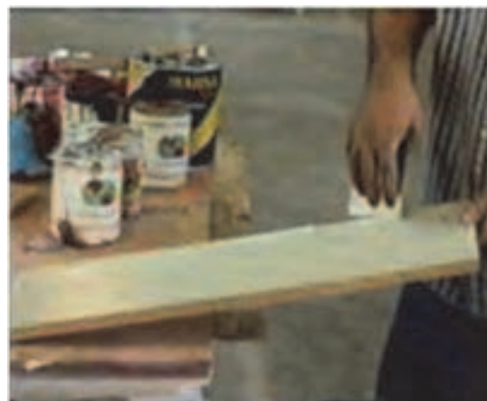
شکل ۱۶- لکه‌گیری با بتونه
