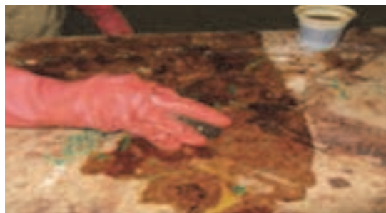
شکل ۲- استفاده از کهنه رنگ کاری برای نفوذ بهتر روغن برزک
