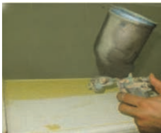
شکل ۳۰- پاشیدن رنگ نیترو سلولزی با پیستوله
