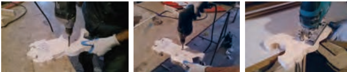
شکل ۶۰- عمل سوراخ‌کاری وسط رحل با دریل دستی
