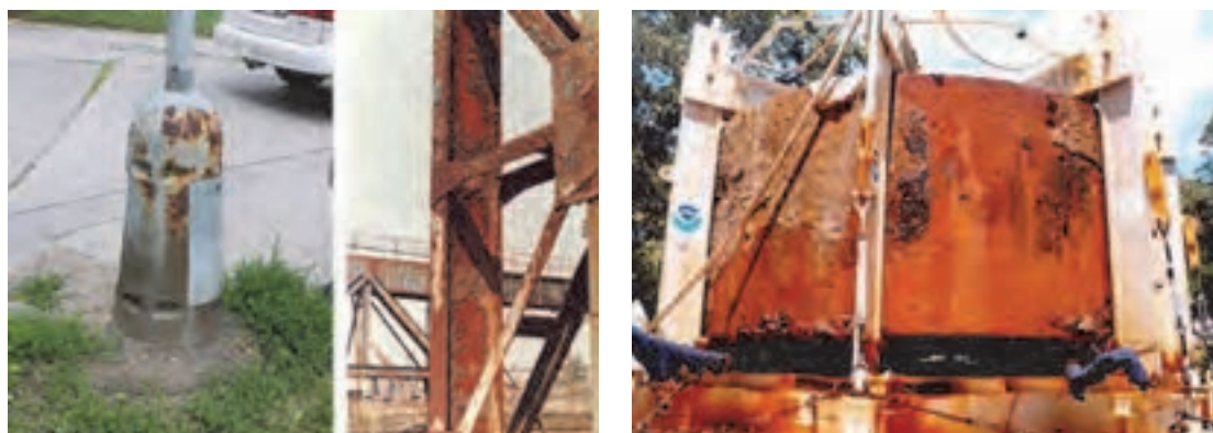
شکل ۵- نمونه‌هایی از خوردگی جوی
