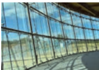
نمای شیشه‌ای با سیستم اسپایدر (سیستم عنکبوتی)
