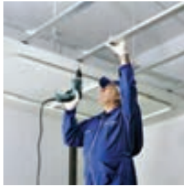
اتصال پانل به زیرسازی توسط پیچ کناف (فاصله پیچ‌ها از یکدیگر ۱۷ سانتی‌متر)
