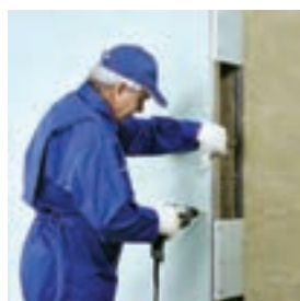
اجرای پانل‌ها در طرف دیگر دیوار
