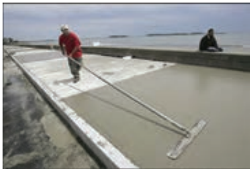
❖ شکل ۳-۵۵ رویه نهایی معابر با بتن درجا
