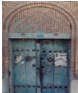
▲ شکل ۴-۷ کاربرد قوس در نعل درگاه
