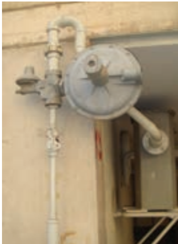
▲ شکل ۹۳-۲ علمک و رگولاتور روی آن
