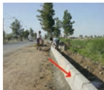
▲ شکل ۳-۳۱ جدول مانع عبور با شیب داخلی
