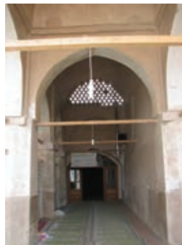
▲ شکل ۴-۷۲ کاربرد چوب در ساخت قوس‌ها
