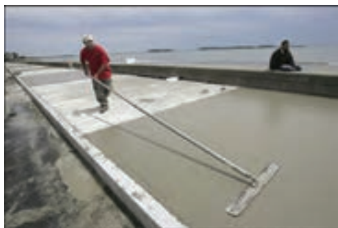
❖ شکل ۳-۵۵ رویه نهایی معابر با بتن درجا
