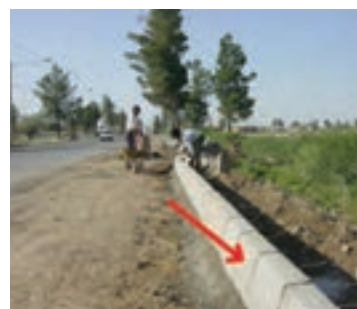
▲ شکل ۳-۳۱ جدول مانع عبور با شیب داخلی
