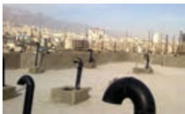
➤ شکل ۲-۵۳ لوله‌های هواکش روی پشت‌بام
