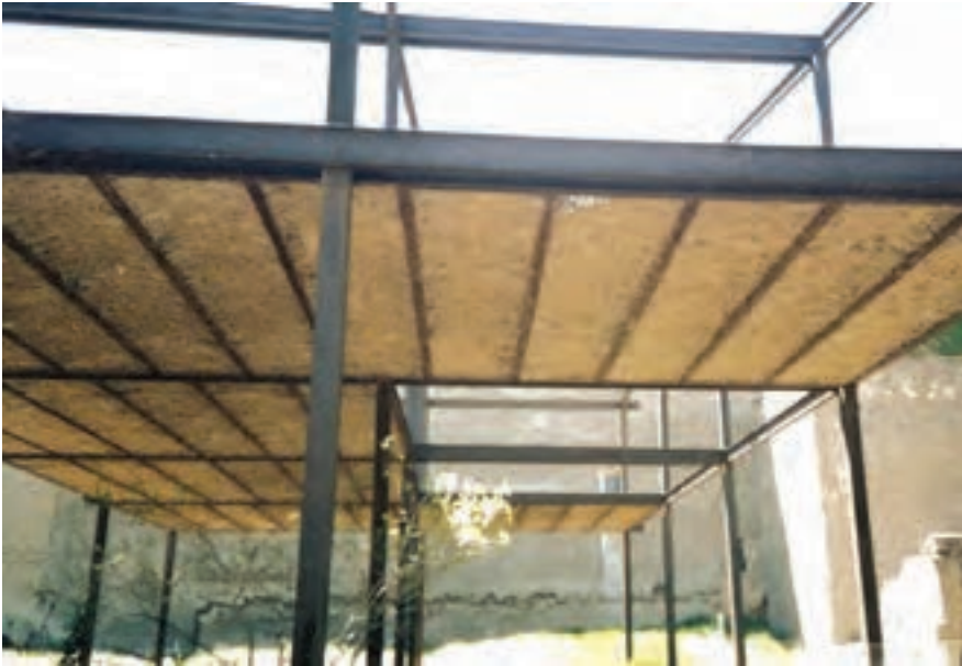
تصویر ۱۰ - تیرریزی سقف طاق ضربی
