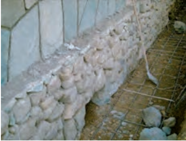
تصویر ۱- پی و دیوار سنگی
