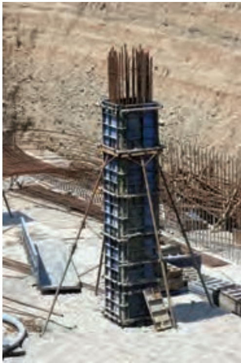
تصویر ۴ - قالب‌بندی فلزی ستون
