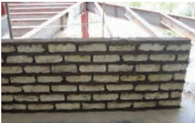
تصویر ۱۴ - دیوار نیم آجره (۱۱ سانتی‌متری)
