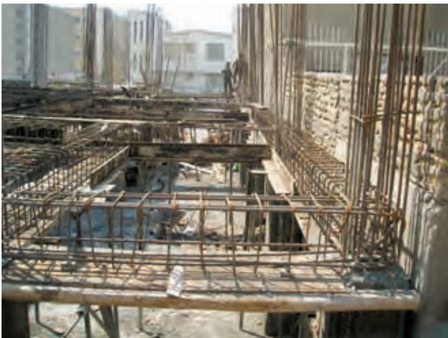
تصویر ۱۲ - نحوه‌ی قرارگیری آرماتورهای کلاف‌های بتنی
