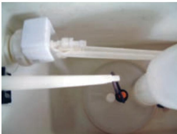
شکل ۲۲۴-۳- بر شدن مخزن فشاری
