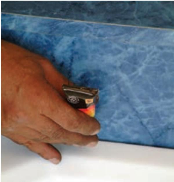
– محل اتصال زیردوشی و دیوار را به وسیله‌ی چسب آببندی، درزبندی می‌کنند (شکل ۳-۱۹۲). در موقع درزبندی باید به تمیز و خشک بودن محل‌های درزبندی توجه شود تا چسب درست به محل‌های تماس بچسبد.
