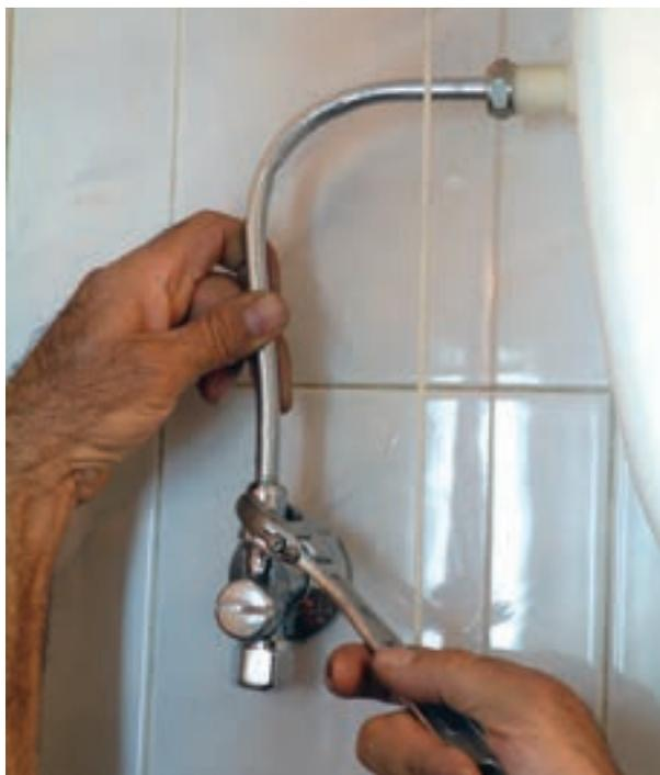
شکل ۲۲۳-۳- اتصال لوله‌ی پیسوار به شیر شناور و شیر پیسوار
