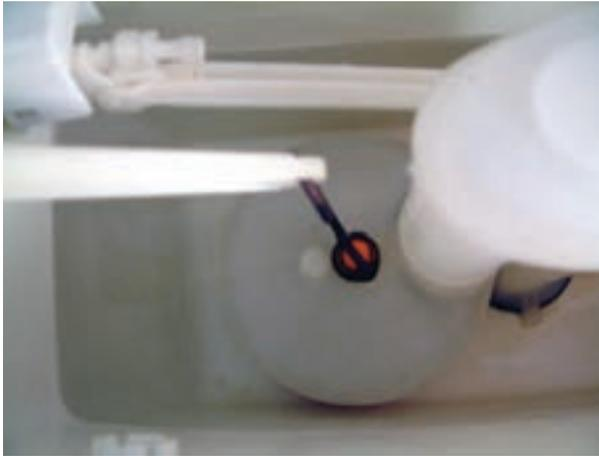
الف - پر شدن مخزن فشاری و قطع کردن شیر شناور
