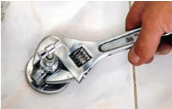
شکل ۲۲۰-۳ سفت کردن شیر پیسوار با آچار فرانسه
