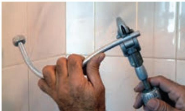
شکل ۲۲۲-۳- بریدن لوله‌ی پیسوار به وسیله‌ی لوله‌بر
