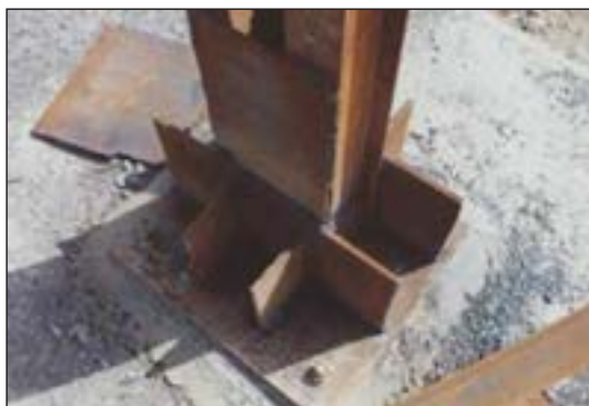
شکل ۱۶۸-۲ اتصال گیردار
