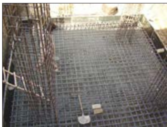
شکل ۱۵۱-۲ آرماتورگذاری پی صفحه‌ای با ستون‌های بتنی
