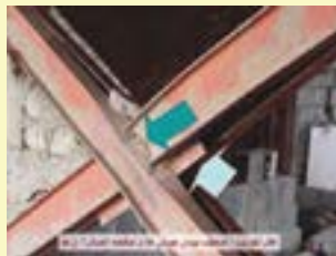
ضعیف بودن جوش و عدم اتصال مناسب
