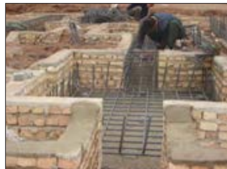
شکل ۱-۸۲ قالب‌بندی آجری در اطراف پی
