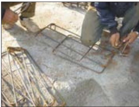
شکل ۲-۱۴۰ خم آرماتور و ساخت خاموت
