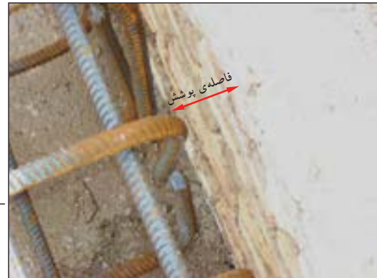
شکل ۲-۱۲۶ فاصله‌ی پوشش و قلاب سر میل‌گردها
