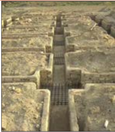
شکل ۴۸-۱ آرماتورگذاری پی تکی کلاف بندی شده
