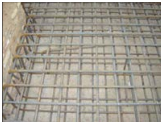
شکل ۱۴۷-۲ پی نواری و آرماتورگذاری آن
