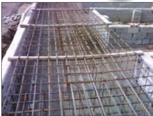
شکل ۱۴۶-۲ پی نواری و آرماتورگذاری آن
