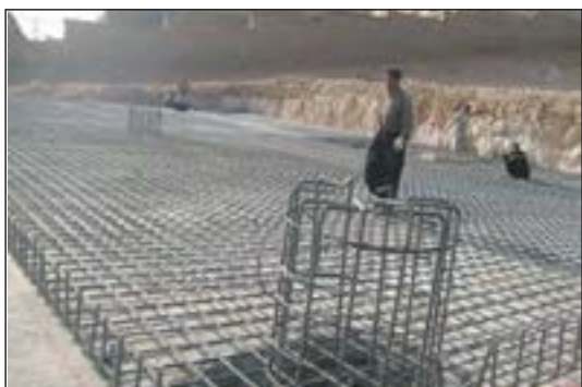
شکل ۱۵۲-۲ آرماتورگذاری پی صفحه‌ای با ستون‌های بتنی
