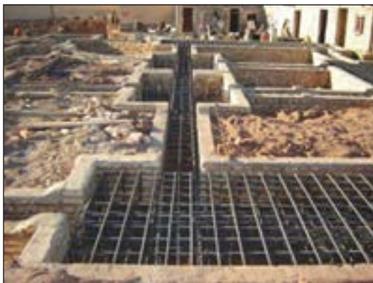
شکل ۷۰-۲ میلگردگذاری در پی کلاف بندی
