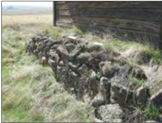
شکل ۱-۳۲ پی سنگی با سنگ لاشه
