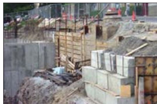
شکل ۹۱-۱ مهاربندی با دیوار مانع چوبی
