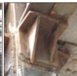
اتصال تیر به ستون به صورت لچکی
