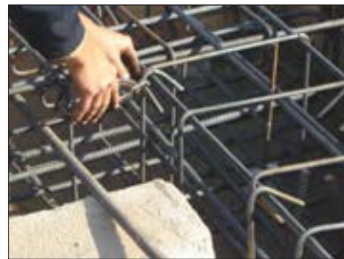
شکل ۲-۱۴۱ بستن خاموت دورآرماتور اصلی شناژ
