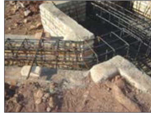
شکل ۲-۱۴۳ آرماتورهای شناژ و پی
