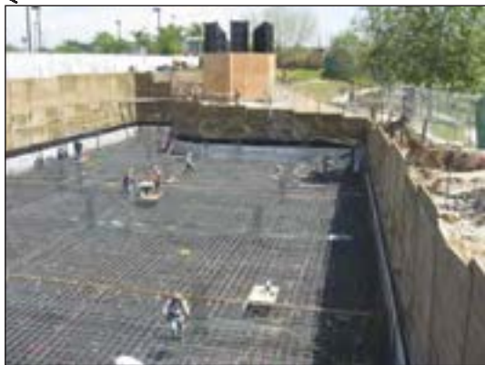
شکل ۱-۶۲ پی بتن مسلح یکپارچه (رادیه ژنرال)
