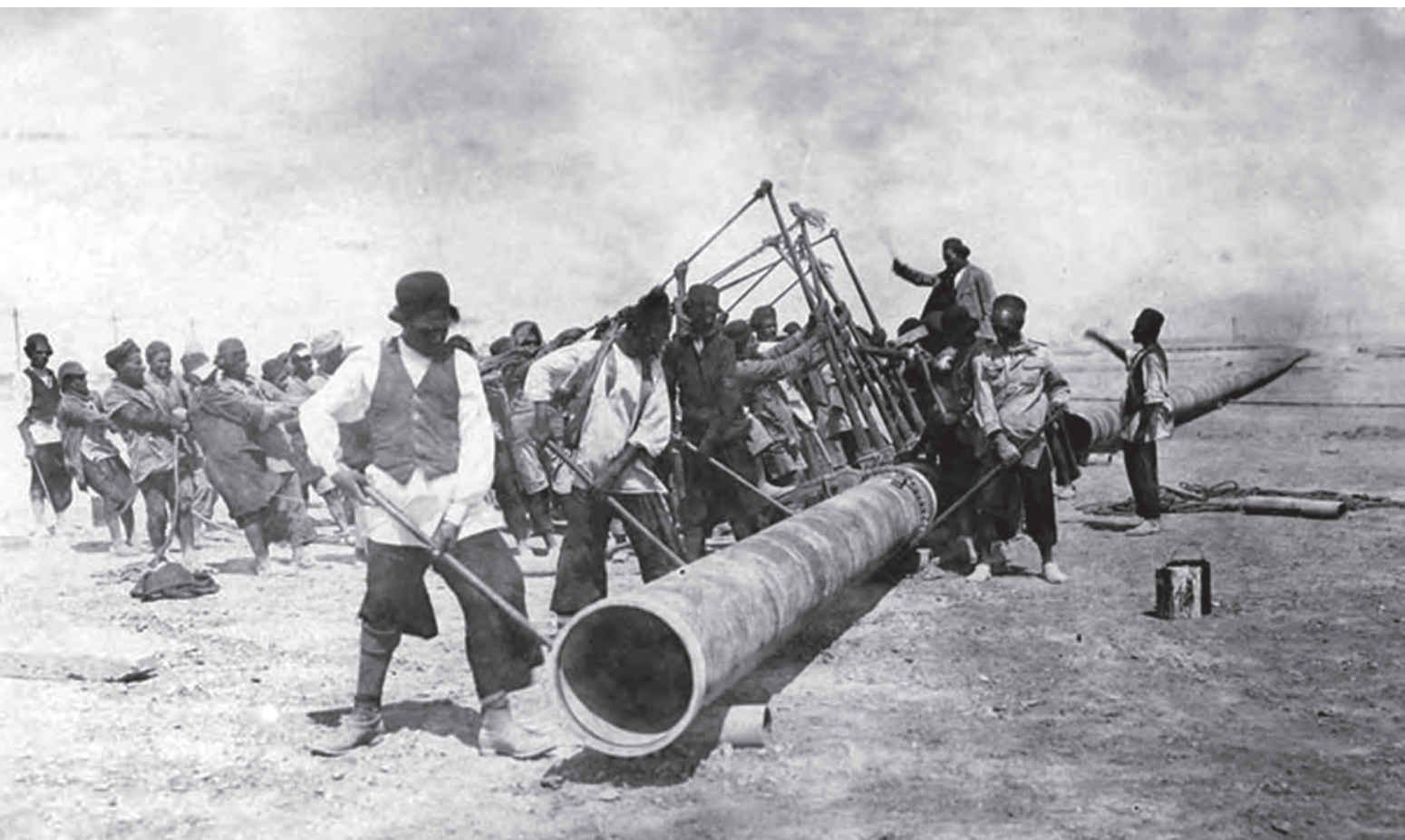
کارگران شرکت نفت هنگام احداث خط لولهٔ نفت در خوزستان
