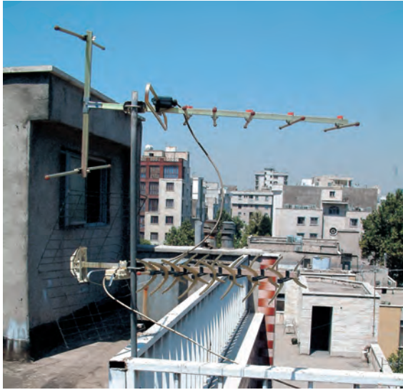
شکل ۱-۶۹- آنتن VHF و UHF روی دکل
