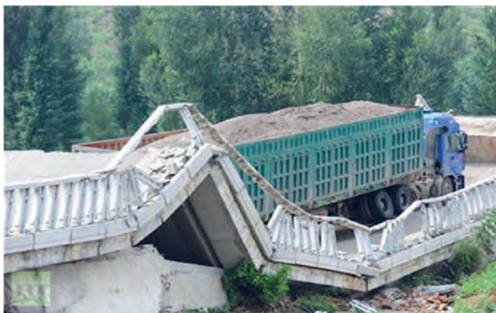
شکل ۲۰- مسیر نامناسب حمل بار و عدم رعایت محدودیت وزنی
