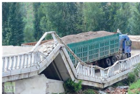
شکل ۱۳- تخریب رویه روسازی و ابنیه فنی
