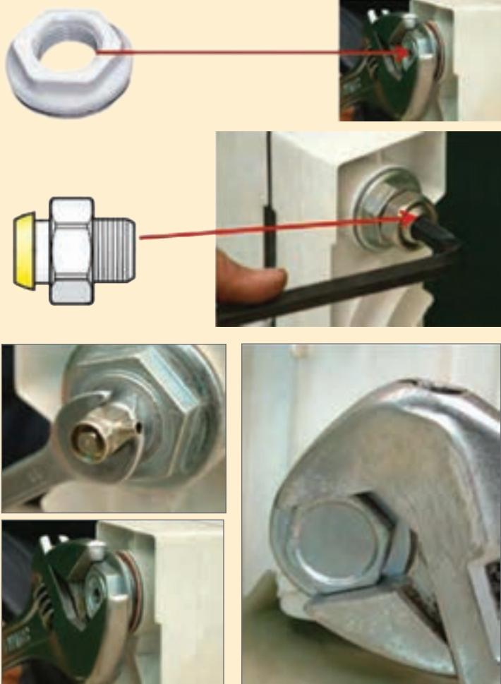
طریقه اتصال تبدیل‌ها (ماسوره‌ها) در جهت رزووه‌های رادیاتور به صورت زیر می‌باشد (دو عدد از ماسوره‌ها راست گرد و دو عدد چپ گرد هستند)
