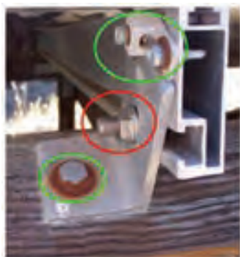
شکل ۵۶- پیچ متصل به سازه فرسوده شده است.
