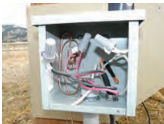
شکل ۳۵- اتصال میله مسی به بدنه تابلو اتصالات
