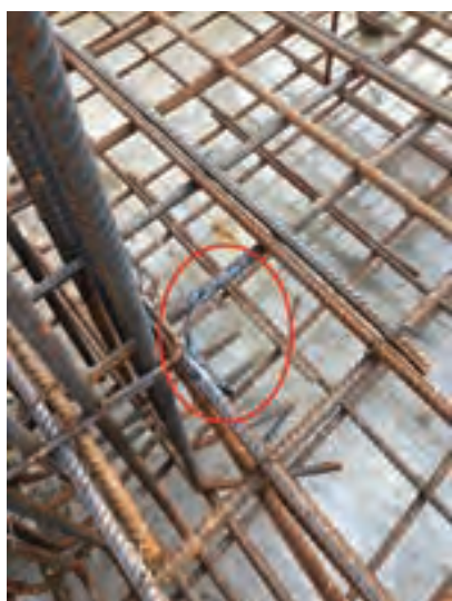
شکل ۲۰- جوشکاری میلگردها در گوشه
