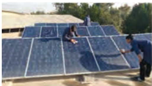
شکل ۴- تمیز کردن مدول‌های خورشیدی
