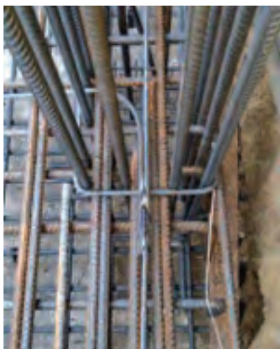
شکل ۲۲- جوشکاری میلگردهای شناژ با شالوده
