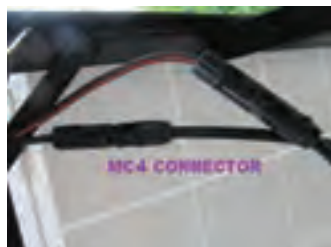
شکل ۲۸- اتصال کانکتور MC۴
