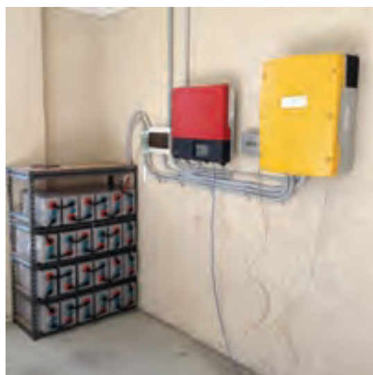
شکل ۶۱- اتصالات سیستم فتوولتائیک
