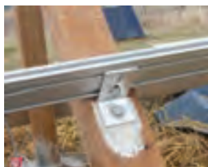
ب) نصب روی پایه آلومینیومی
