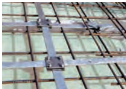
شکل ۹ - تسمه همبندی
