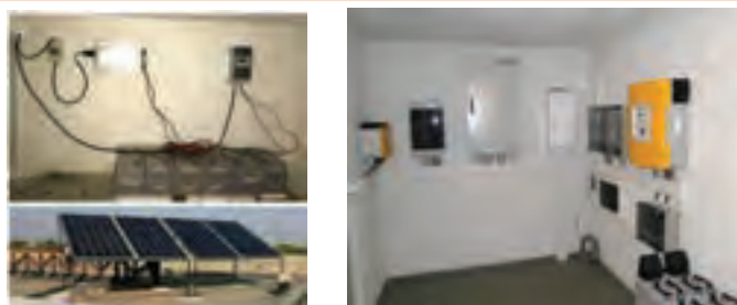
شکل ۴۶- اجرای دو نمونه سیم کشی سیستم فتوولتاییک
