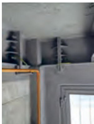
شکل ۲۴- اتصال اسکلت فلزی پیچی
