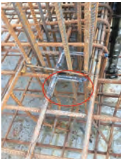
شکل ۱۹- جوشکاری میلگردها در یک تقاطع چهارراه
