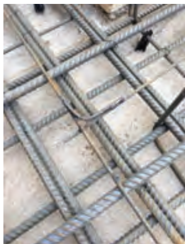
شکل ۲۱- جوش کاری میلگردها در تقاطع سه راهه
