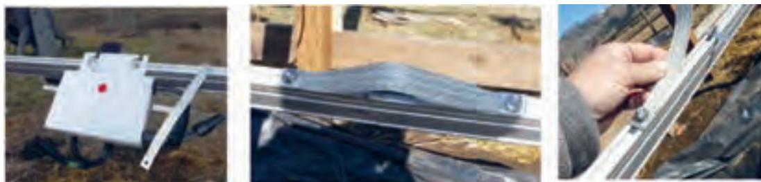
شکل ۲۹- همبندی در سامانه فتوولتاییک
