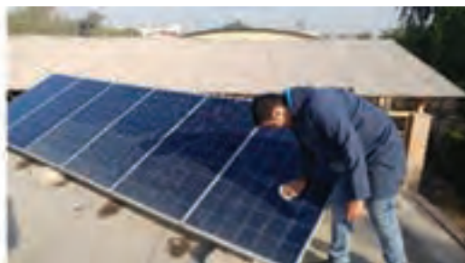
شکل ۵- تمیز کردن با پارچه نرم و آب
