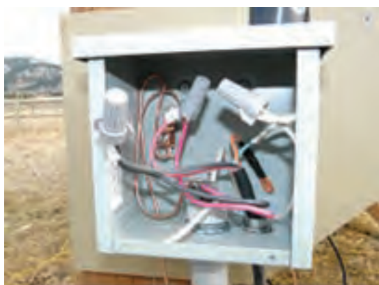
شکل ۳۵- اتصال میله مسی به بدنه تابلو اتصالات
