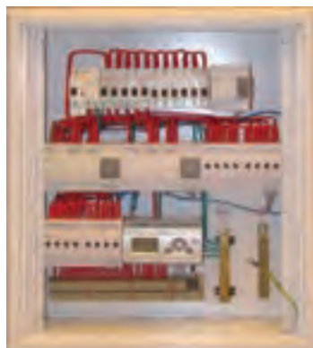
شکل ۵۳- دو نمونه تابلوی توزیع برق (DP)
