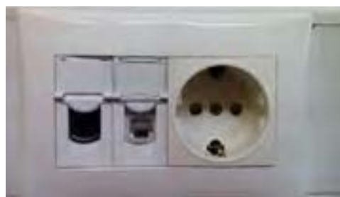
شکل ۱۱- قاب رو و اتصالات پریز برق، تلفن و شبکه رایانه
