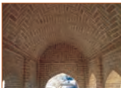
ب- استفاده از آجر برای سقف قوسی
