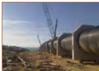
ت - احداث خطوط لوله
