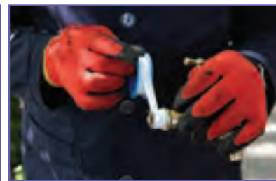
پ- پیچیدن نوار تفلون روی شیر نو
