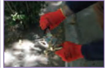
پ - باز کردن کلگی شیر با آچار در جهت پاد ساعتگرد
