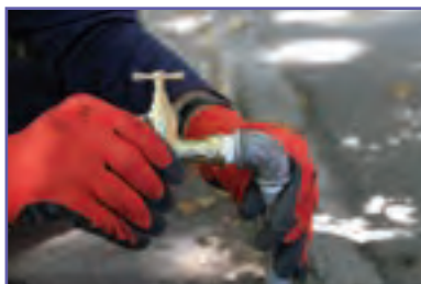
ت- بستن شیر با دست به لوله
