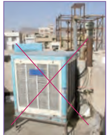
ب - فاصله بین دودکش تا کولر آبی و یا پ - برای خروجی دودکش هر دستگاه درپچه های تأمین هوای ساختمان دست کم سه متر باشد.
