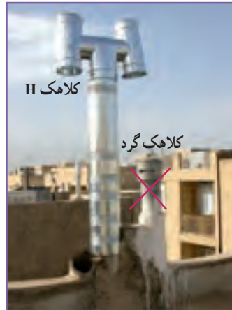
پ - برای خروجی دودکش هر دستگاه گاز سوز یک کلاhek H نصب شود.
