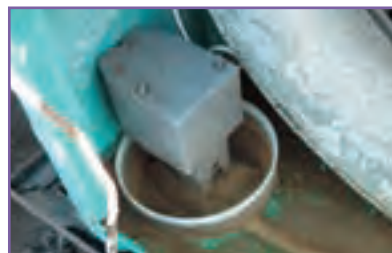
ج - بررسی و تمیز کردن پمپ آب
