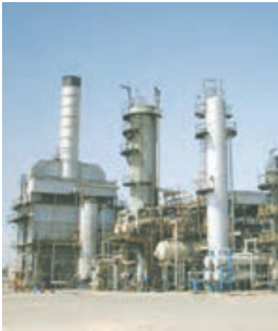
ب) نمای بیرونی برج تقطیر در پالایشگاه
