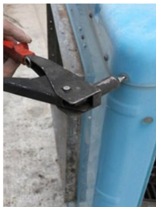
شکل - اتصال بدنه کولر با پرچ
