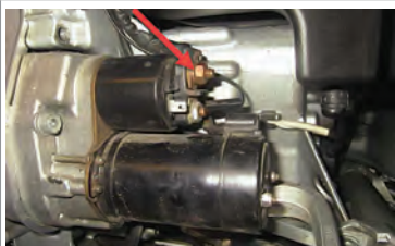
باز کردن مهره ترمینال B و کابل ترمینال مثبت باتری
