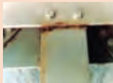
عدم جوشکاری کامل در محل اتصال
