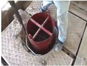
جوشکاری پروفیل در مرکز شابلون برای جلوگیری از دفرمه شدن شابلون
