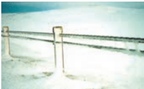
شکل ۹- در این تصاویر وضعیت جداول بتنی در نقاط برف گیر با سیستم کابلی مقایسه شده است که دید واضحی در مهار کابلی در این نقاط مشاهده می شود.
