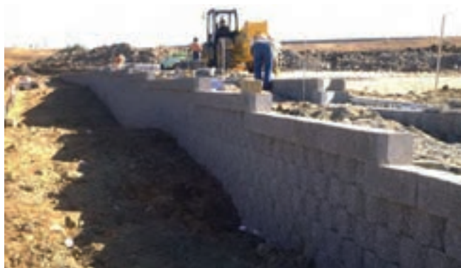
شکل ۱۸- نمونه ای از محل کاربرد دیوار حایل
