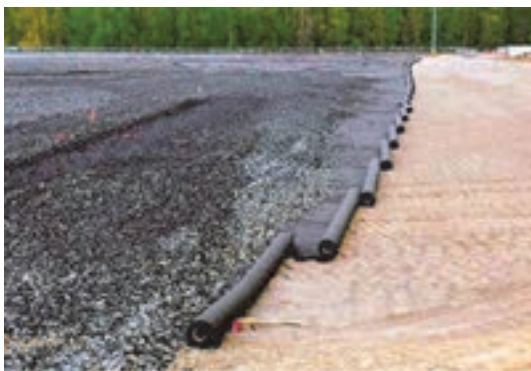
شکل ۱۵- نمونه اجرای ژئوسنتتیک
