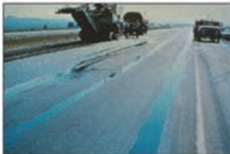
شکل ۱- نمونه‌ای از خرابی گودی مسیر چرخ
