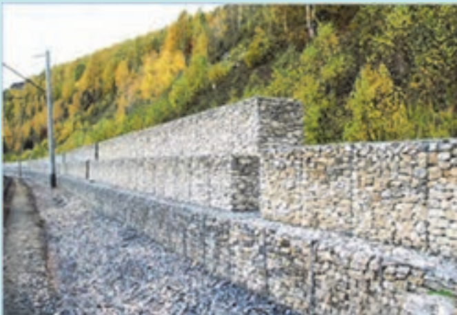
نمونه اجرایی گابیون بندی
