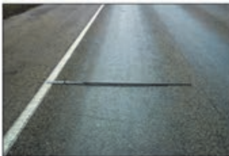
شکل ۱- نمونه‌ای از خرابی گودی مسیر چرخ
