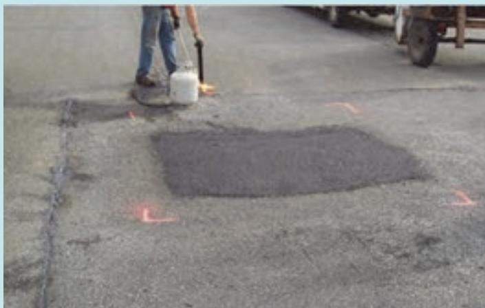
شکل ۱۳ - نحوه مشخص کردن محدوده خرابی برای لکه گیری
