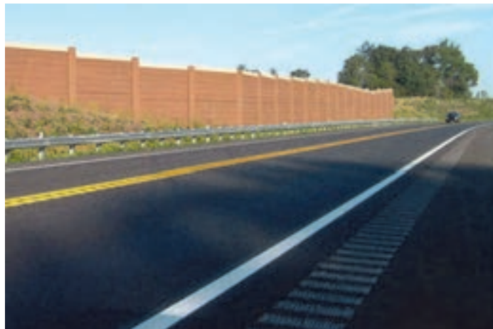
شکل ۲۰- دیوارهای حایل صوتی در بزرگراه‌ها
