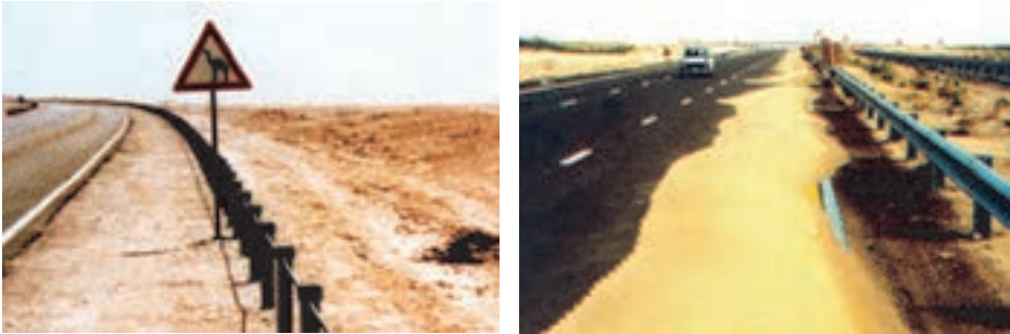
شکل ۱۰- در این تصاویر مقایسه‌ای بین گاردریل و سیستم کابلی در نقاط صحرایی انجام شده است و رفع مشکل انباشت ماسه با استفاده از سیستم کابلی صورت گرفته است.
