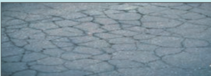
شکل ۱۵ - ترک با الگوی پوست سوسماری
