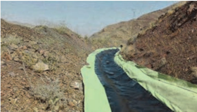
شکل ۱۶- نمونه اجرای ژئوسنتتیک
