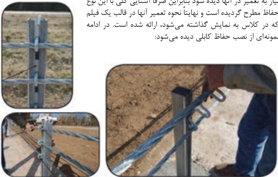
شکل ۱۱- نمونه‌ای از اجرای حفاظ کابلی
