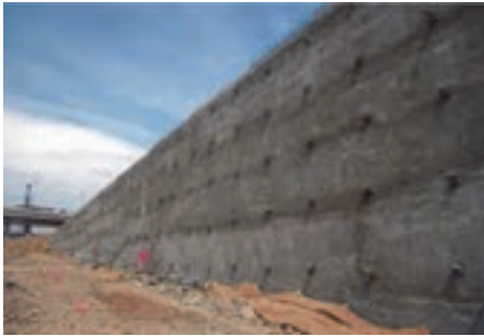
شکل ۹- میخ‌کوبي خاک (نیلینگ)
