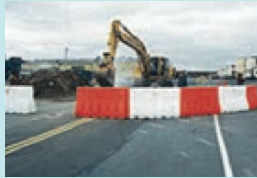
هدایت موقت ترافیک در مناطق کارگاهی
