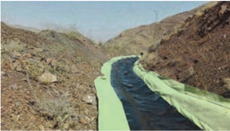
شکل ۱۶- نمونه اجرای ژئوسنتتیک
