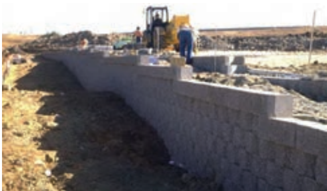
شکل ۱۸- نمونه ای از محل کاربرد دیوار حایل
