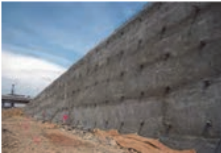
شکل ۹- میخ‌کوبی خاک (نیلینگ)
