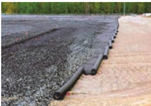
شکل ۱۵- نمونه اجرای ژئوسنتتیک
