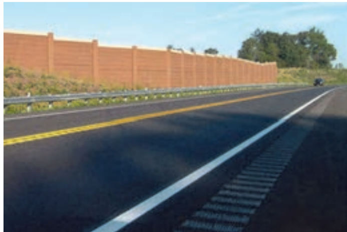
شکل ۲۰- دیوارهای حایل صوتی در بزرگراه‌ها
