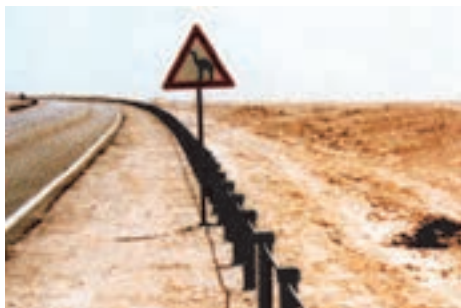
شکل ۱۰- در این تصاویر مقایسه‌ای بین گاردریل و سیستم کابلی در نقاط صحرایی انجام شده است و رفع مشکل انباشت ماسه با استفاده از سیستم کابلی صورت گرفته است.
