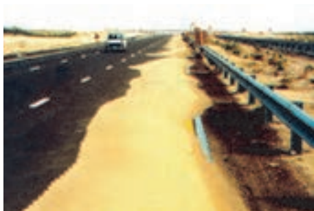
شکل ۱۰- در این تصاویر مقایسه‌ای بین گاردریل و سیستم کابلی در نقاط صحرایی انجام شده است و رفع مشکل انباشت ماسه با استفاده از سیستم کابلی صورت گرفته است.
