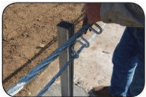
شکل ۱۱- نمونه‌ای از اجرای حفاظ کابلی
