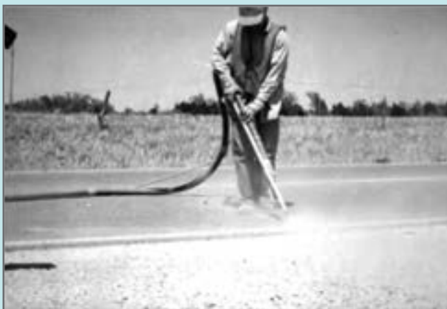
شکل ۱۲ - ماسه پاشی به همراه راهنمای چوبی متصل به آن
