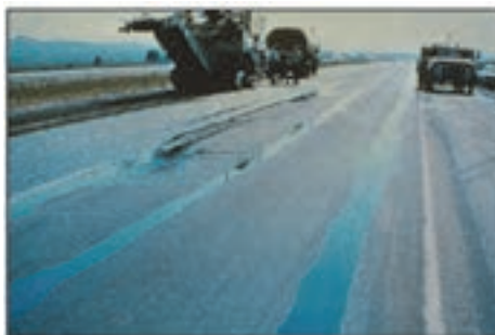
شکل ۱- نمونه‌ای از خرابی گودی مسیر چرخ
