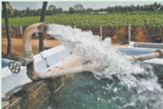
شکل ۳۰-۵. لوله برگشت آب
