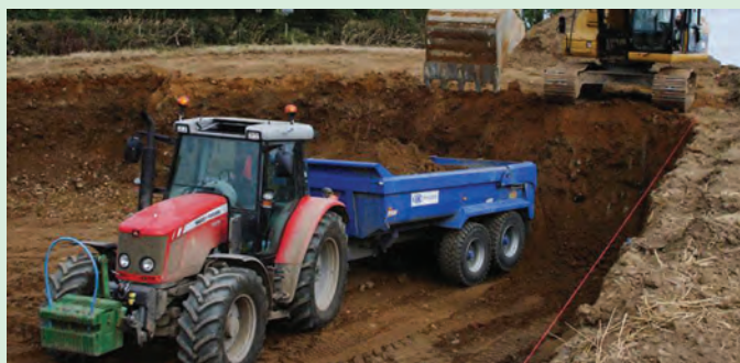
شکل ۲۱-۴- بارگیری نامناسب پی نورد
