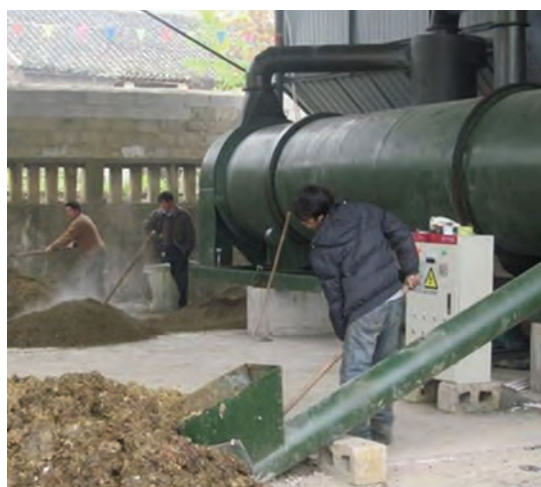
خشک کردن کود مرغ با سیستم خشک کن علامت اخطار: عدم رعایت اصول ایمنی
