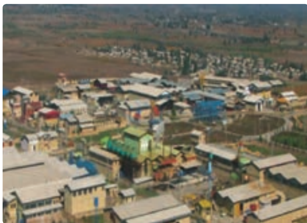
شکل ۲-۴- شهرک صنعتی علی آباد
