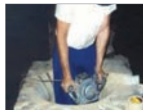
شکل ۱۳- کوبیدن نسوز کف کوره با کوبه ماشینی
