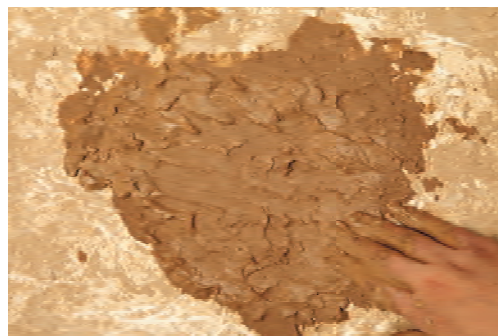
شکل ۱۱- تهیه گل یکنواخت با دوغاب
