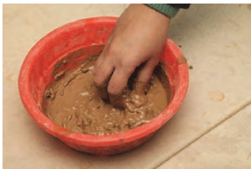
شکل ۱۱- تهیه گل یکنواخت با دوغاب
