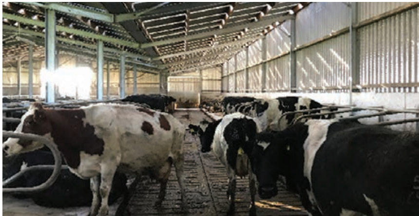
استفاده از کف مشبک در جایگاه
