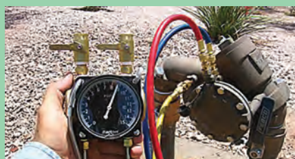
شکل ۱۷- تنظیم فشار شیر فشارشکن
