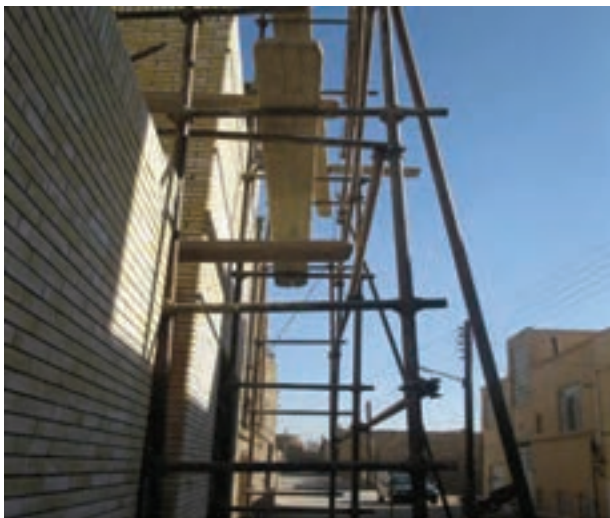
شکل ۱-۱: داربست فلزی برای چیدن دیوار
