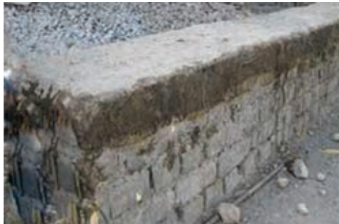
شکل ۱- ۲۹ : کرسی چینی یا عایق کاری رطوبتی
