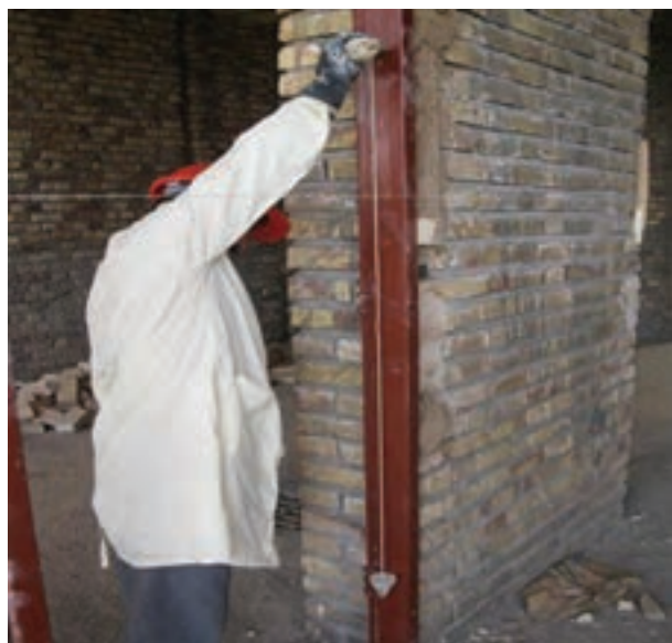
شکل ۳-۲۳: شاقول کردن وادار
