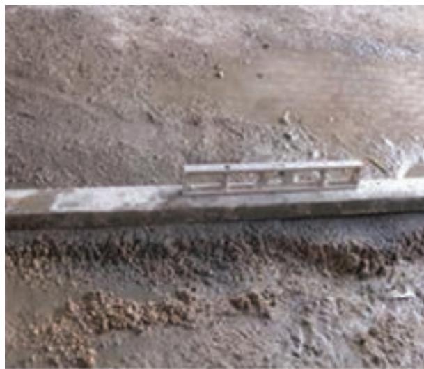
شکل ۱- ۶۹: تراز کردن روی ملات
