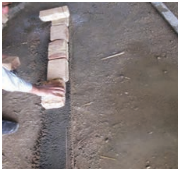
شکل ۱ - ۹۱ : نحوه چین آجر در امتداد ریسمان کار
