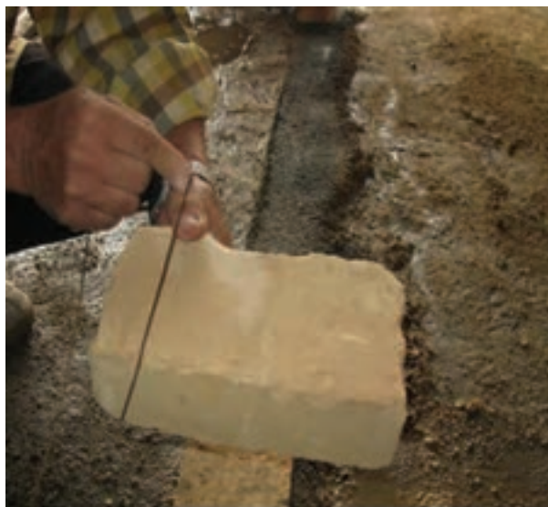
شکل ۱- ۷۲: نحوه بستن ریسمان کار به آجر
