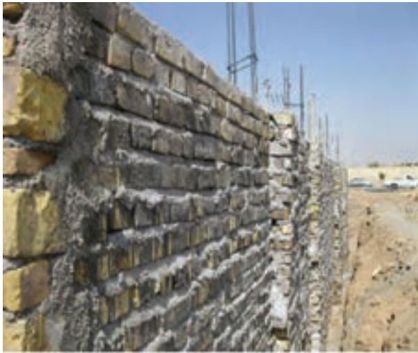
شکل ۱ - ۲۶: دیوار آجری با کلاف بندی قائم
