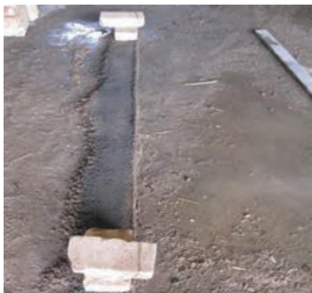
شکل ۱- ۹۰: بادخور نمودن ریسمان کار
