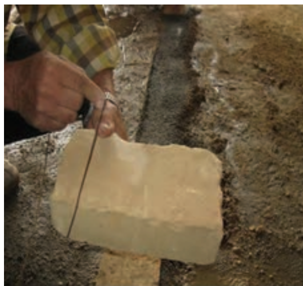
شکل ۱- ۸۹: نحوه بستن ریسمان کار به آجر
