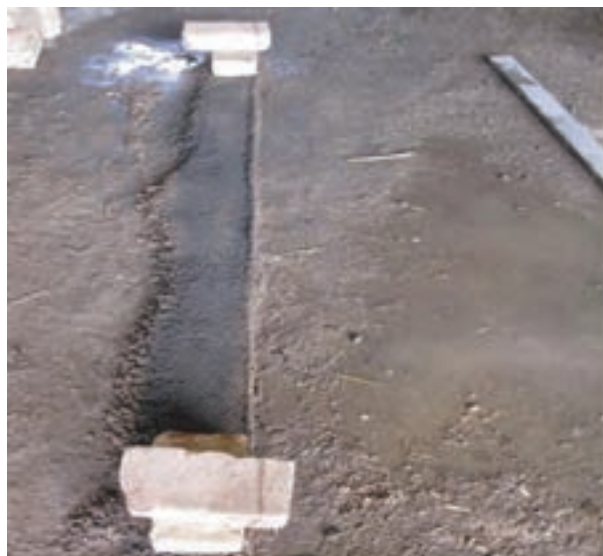
شکل ۱- ۷۳: بادخور نمودن ریسمان کار
