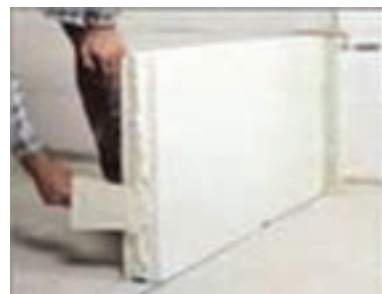
شکل ۱ - ۳۶: طریقه نصب بلوک های گچی
