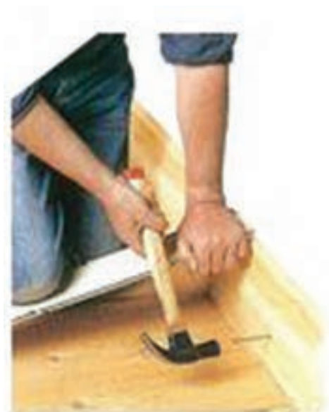
شکل ۳- ۲۹: نصب قرنیز چوبی با میخ
