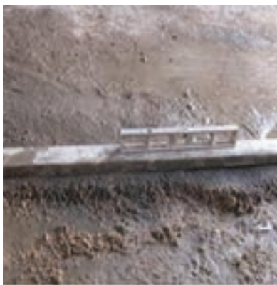
شکل ۱- ۱۰۵: تراز کردن روی ملات
