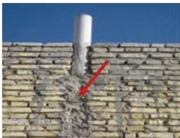
شکل ۱ - ۶۵: پر کردن درز لوله‌ها
