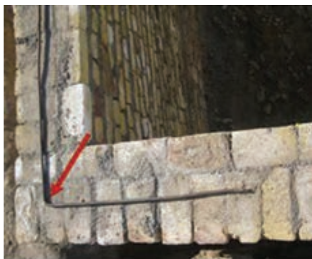
شکل ۱ - ۵۵: میلگرد گذاری در محل اتصال دو دیوار
