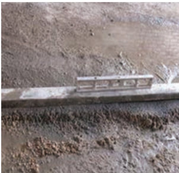
شکل ۱ - ۸۶: کنترل تراز سطح ملات
