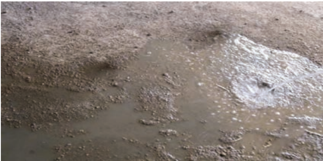
شکل ۱ - ۶۷: خیس کردن سطح زیر کار
