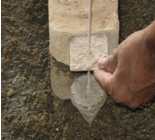
شکل ۱- ۷۷: شاقول کردن نبش کار
