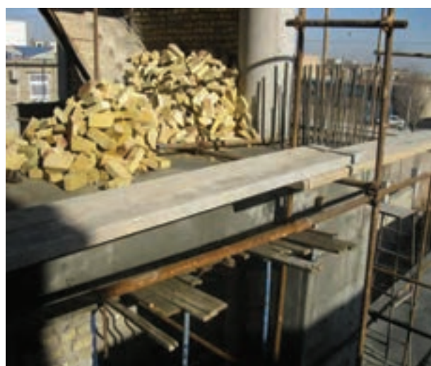
شکل ۱-۲: ضخامت مناسب برای تخته زیر پایی
