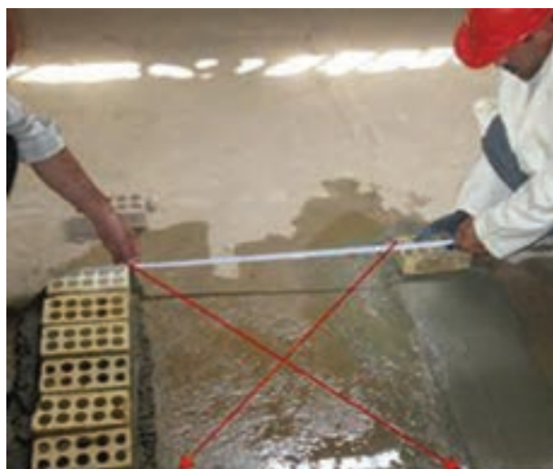
شکل ۱ - ۳۳ (ب): جدا کردن اندازه دو طرف دیگر
