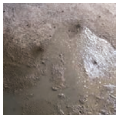
شکل ۱- ۱۰۳: خیس کردن سطح زیر کار
