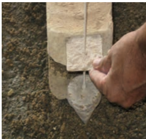
شکل ۱ - ۹۴ : شاقول کردن نبش کار
