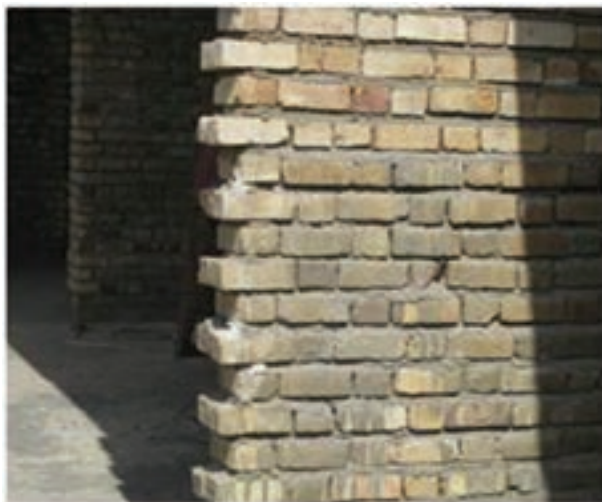
شکل ۱ - ۵۲: لابند در دیوار آجری
