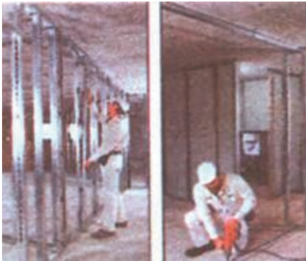
شکل ۱-۴۴: قاب سازی جهت اتصال روکش های گچی
