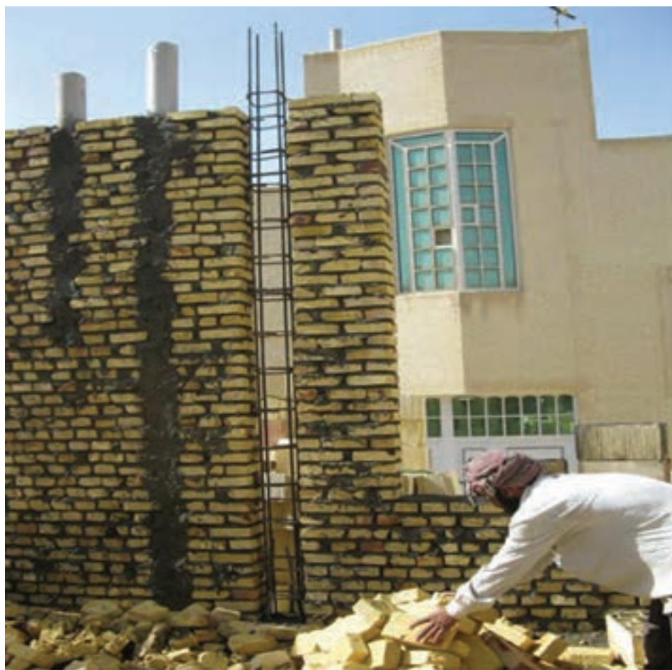
شکل ۱ - ۶۰: اتصال کلاف قائم و افقی در دیوار
