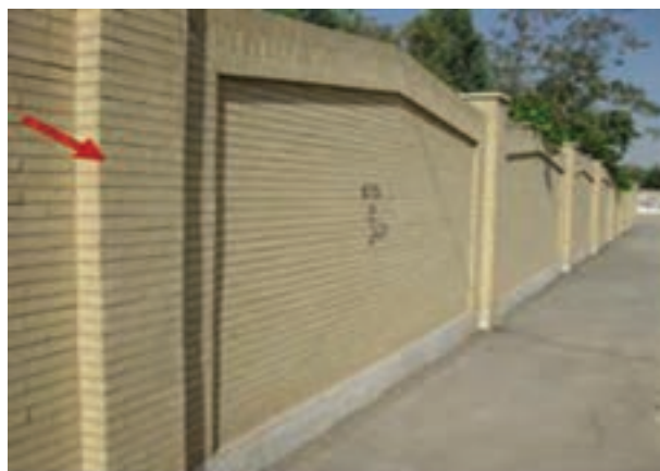
شکل ۱ - ۵۸: وابند در دیوار حصارکشی
