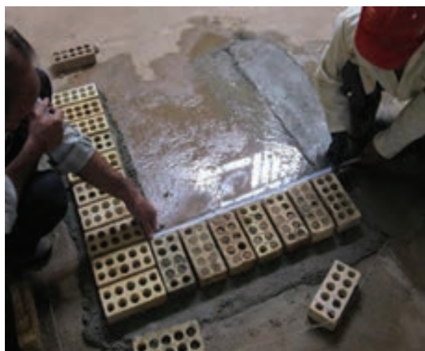
شکل ۱ - ۳۳ (الف): برداشتن طول دیوار
