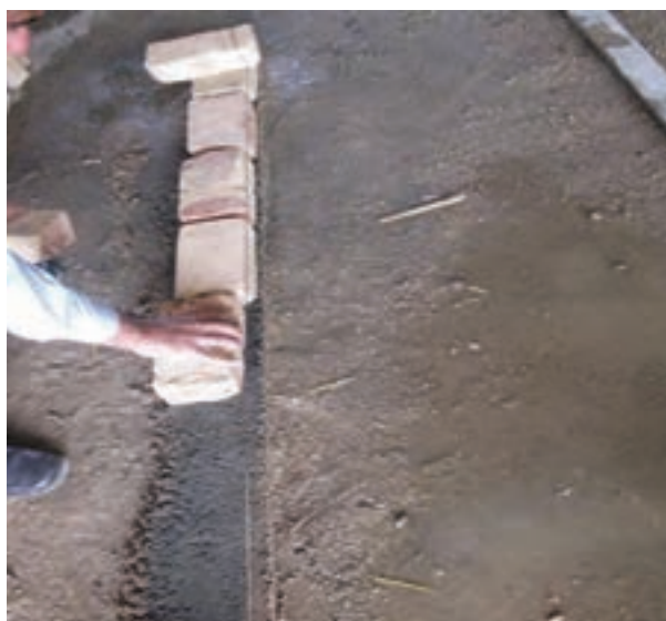
شکل ۱- ۷۴: نحوه چیدن آجر در امتداد ریسمان کار
