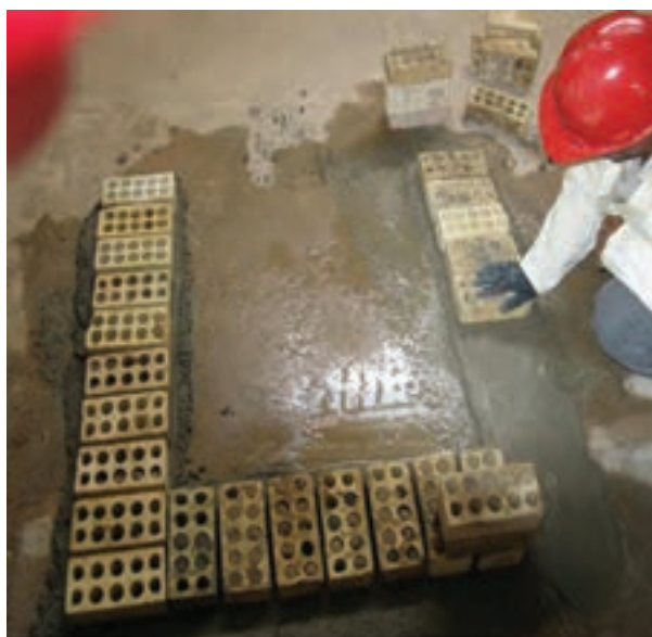
شکل ۱ - ۳۳ (ج): ریسمان کشی و چیدن ضلع سوم
