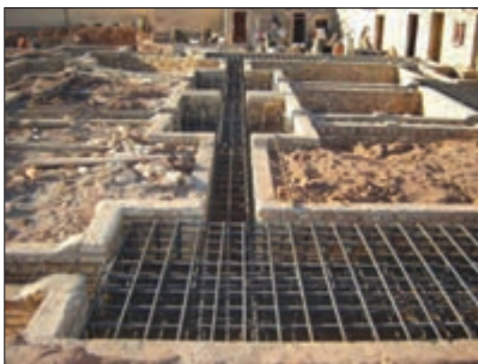
شکل ۳-۱۳۴ میلگردگذاری در پی کلاف‌بندی
