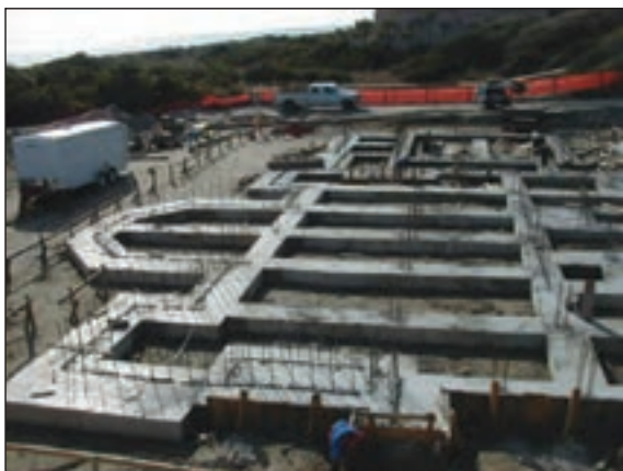
شکل ۳-۶۲ پی بتن مسلح نواری شبکه ای زیرستون
