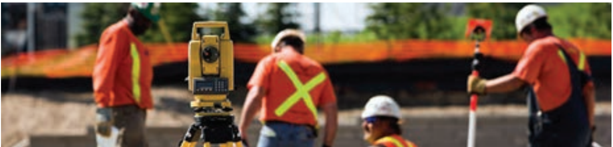
شکل ۴-۱. پیاده کردن با دوربین نقشه برداری
