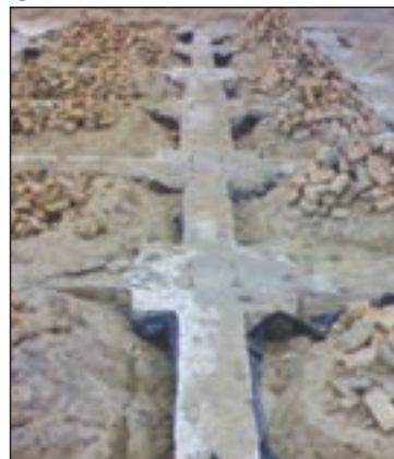
شکل ۳-۱۳۷ پی و شناژ بعد از بتن‌ریزی
