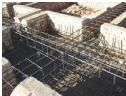
شکل ۳-۱۳۵ عبور میلگردهای شناژ در پی
