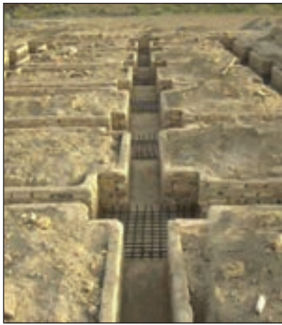
شکل ۳-۵۴ آرماتورگذاری پی تکی کلاف بندی شده
