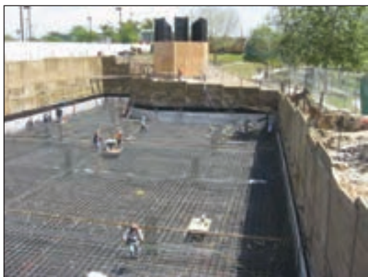
شکل ۳-۶۸ پی بتن مسلح یکپارچه (رادیه ژنرال)
