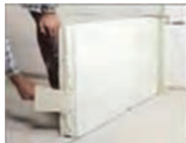
شکل ۱ - ۳۶: طریقه نصب بلوک های گچی
