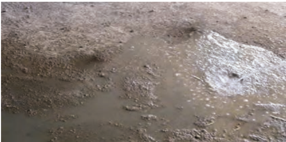
شکل ۱- ۶۷: خیس کردن سطح زیر کار
