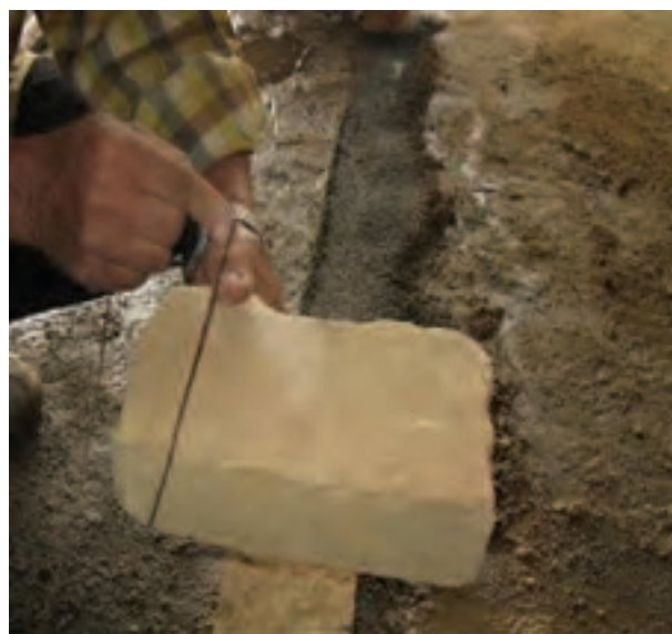
شکل ۸۹-۱: نحوه بستن ریسمان کار به آجر
