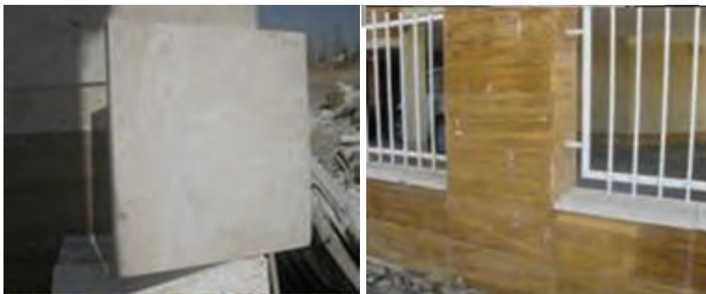
شکل ۱-۱۸ : کاربرد سنگ رسوبی در نما
