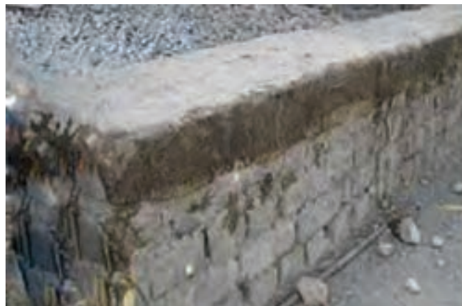
شکل ۱- ۲۹: کرسی چینی یا عایق کاری رطوبتی
