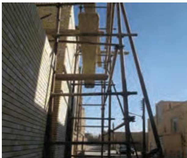
شکل ۱-۱: داربست فلزی برای چیدن دیوار
