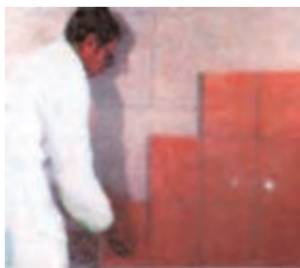
شکل ۱ - ۴۳: نصب کاشی روی قطعات پیش ساخته گچی
