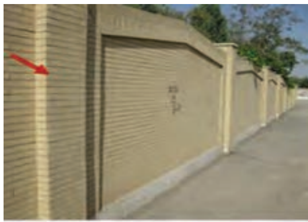
شکل ۱ - ۵۸: وابند در دیوار حصارکشی
