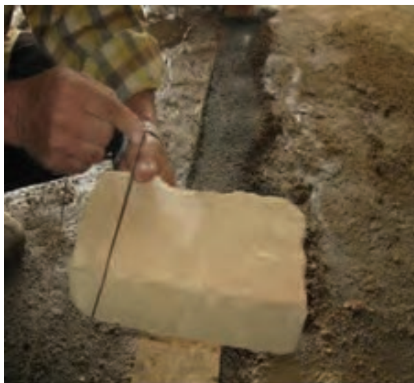
شکل ۱- ۷۲: نحوه بستن ریسمان کار به آجر
