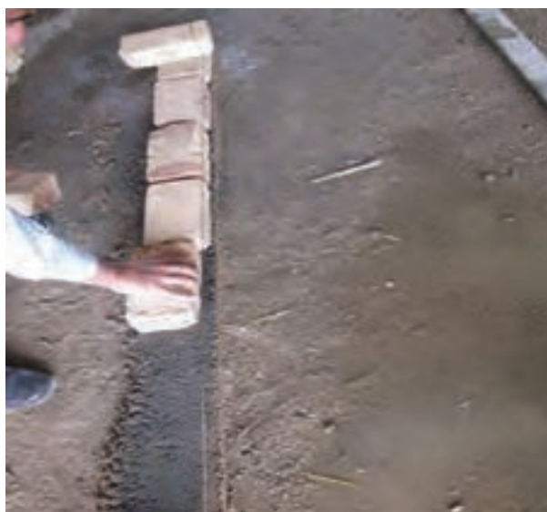
شکل ۱- ۷۴: نحوه چیدن آجر در امتداد ریسمان کار
