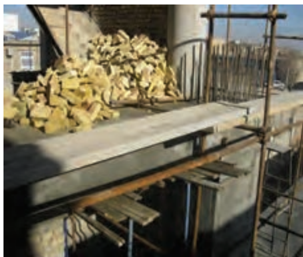
شکل ۱-۲: ضخامت مناسب برای تخته زیر پایی
