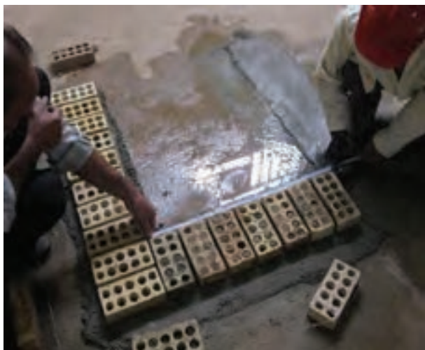
شکل ۱ - ۳۳ (الف): برداشتن طول دیوار
