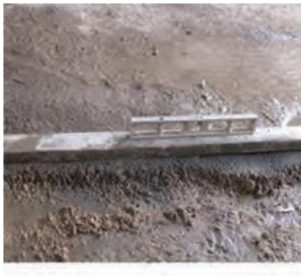
شکل ۱- ۶۹: تراز کردن روی ملات
