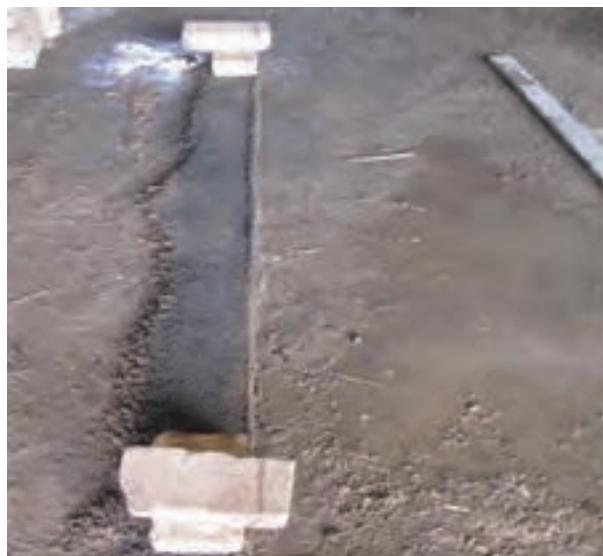
شکل ۱- ۷۳: بادخور نمودن ریسمان کار
