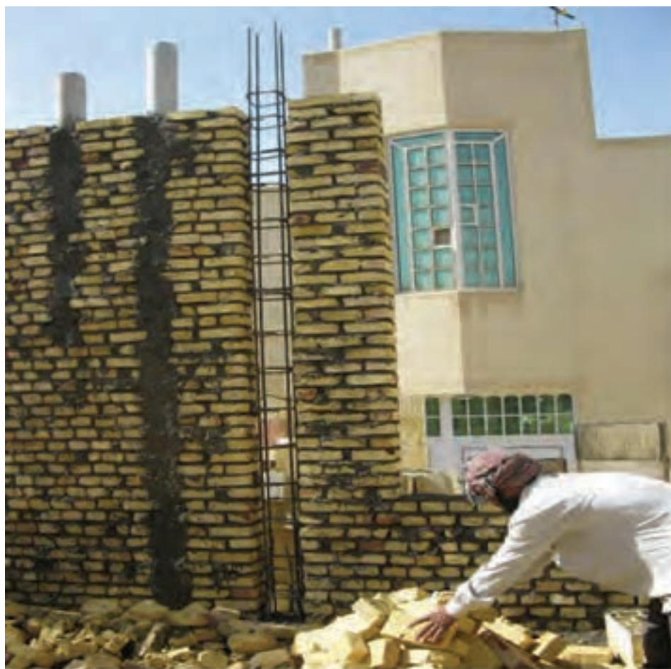
شکل ۱ - ۶۰: اتصال کلاف قائم و افقی در دیوار
