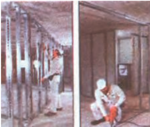
شکل ۱-۴۴: قاب سازی جهت اتصال روکش های گچی
