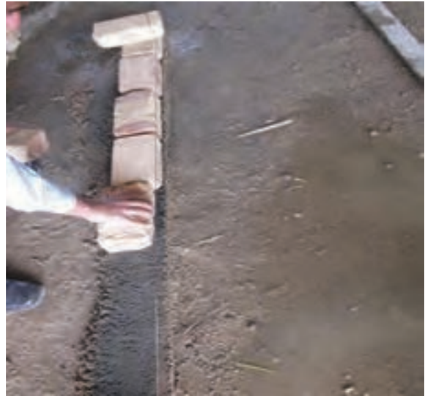
شکل ۱ - ۹۱ : نحوه چین آجر در امتداد ریسمان کار
