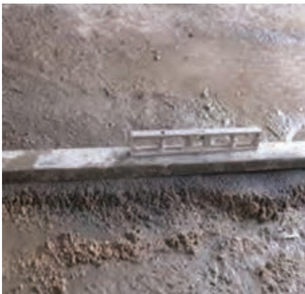
شکل ۱ - ۸۶: کنترل تراز سطح ملات
