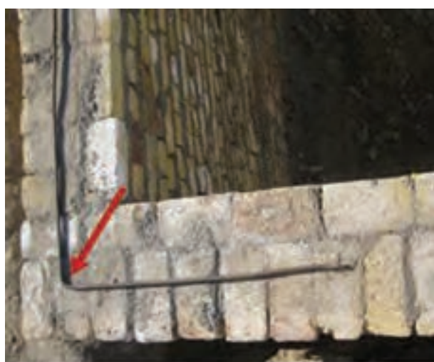
شکل ۱ - ۵۵: میلگرد گذاری در محل اتصال دو دیوار
