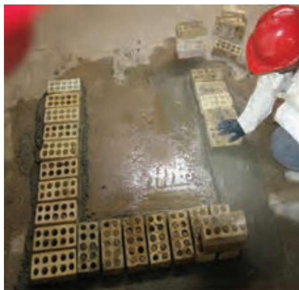
شکل ۱ - ۳۳ (ج): ریسمان کشی و چیدن ضلع سوم
