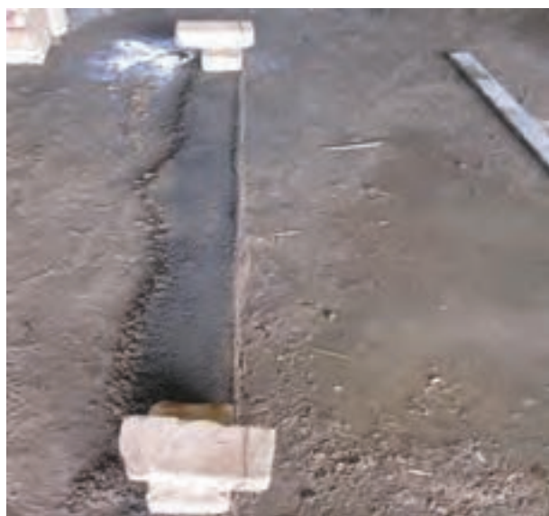
شکل ۹۰-۱: بادخور نمودن ریسمان کار
