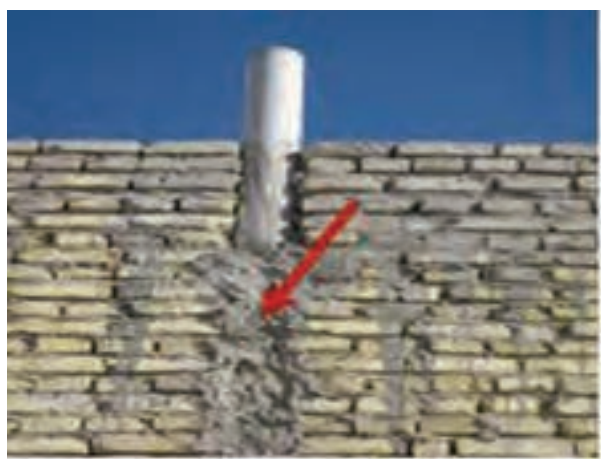
شکل ۱ - ۶۵: پر کردن درز لوله‌ها
