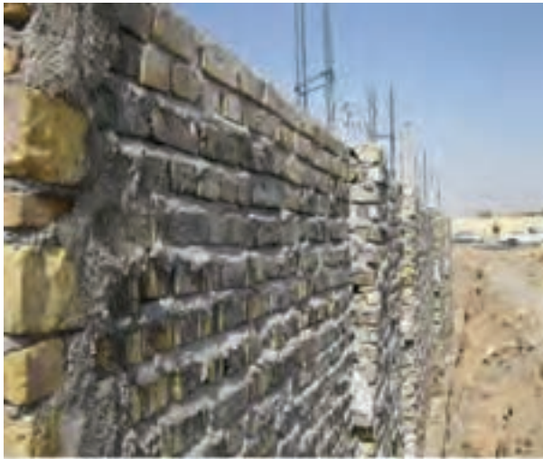
شکل ۱ - ۲۶: دیوار آجری با کلاف بندی قائم
