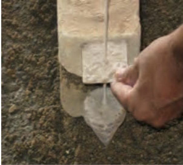
شکل ۱- ۷۷: شاقول کردن نبش کار
