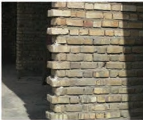
شکل ۱-۵۲: لابند در دیوار آجری
