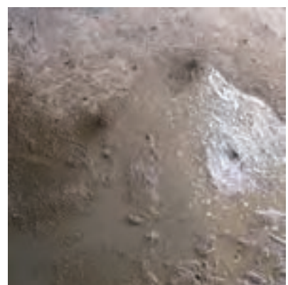
شکل ۱- ۱۰۳: خیس کردن سطح زیر کار
