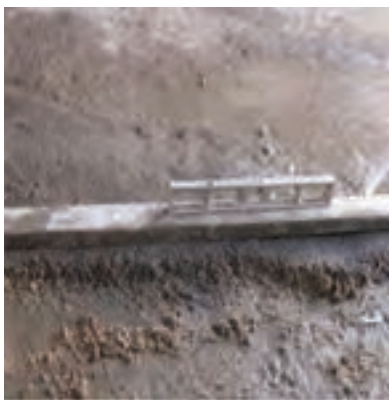
شکل ۱- ۱۰۵: تراز کردن روی ملات
