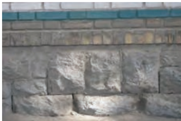
شکل ۱ - ۱۵ : کاربرد سنگ در پایه های ساختمان
