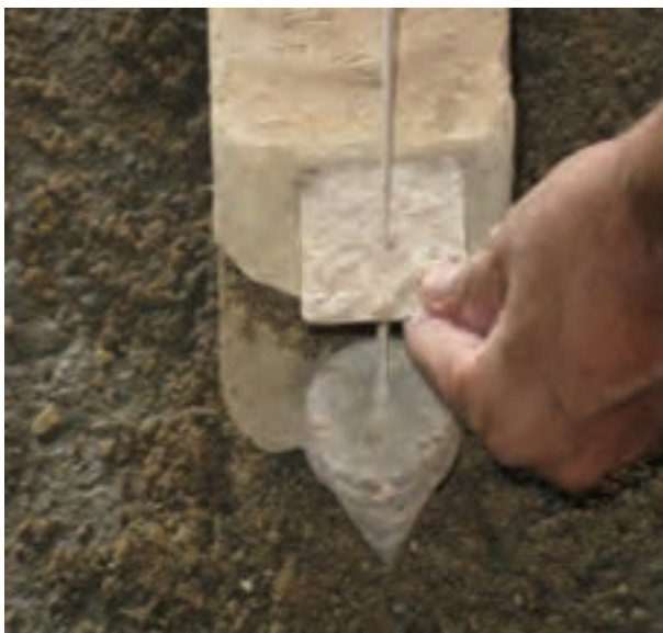
شکل ۱ - ۹۴ : شاقول کردن نبش کار
