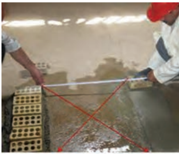
شکل ۱ - ۳۳ (ب): جدا کردن اندازه دو طرف دیگر
