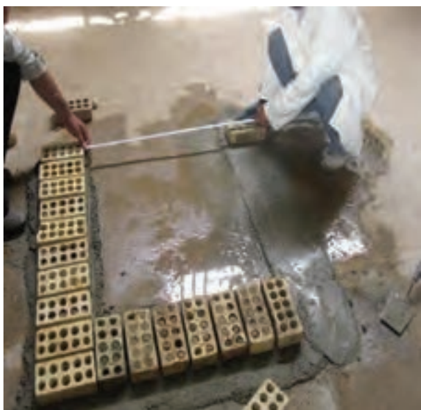
شکل ۱ - ۳۳ (ب): جدا کردن اندازه دو طرف دیگر
