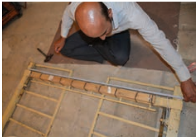
شکل ۱۶-۵ - نصب چوب پایین کشی پشت زیردار
