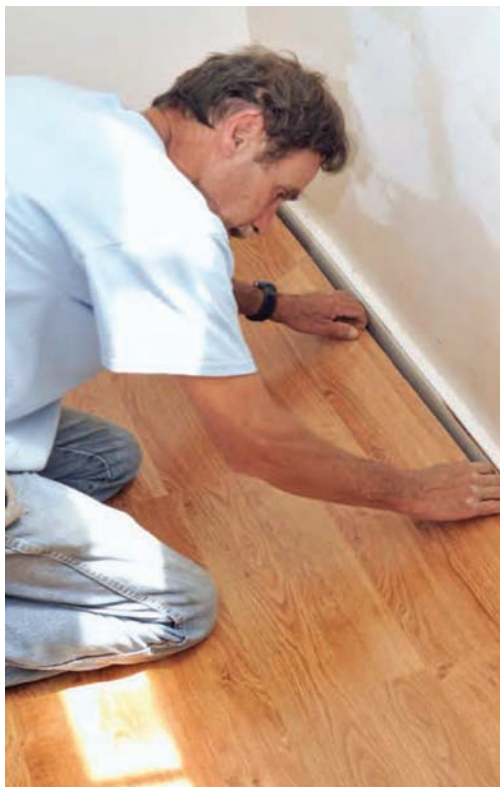
سمت چپ: نصب قطعات لمینت، سمت راست: نصب آخرین قطعات لمینت در جوار قرنیز موجود
