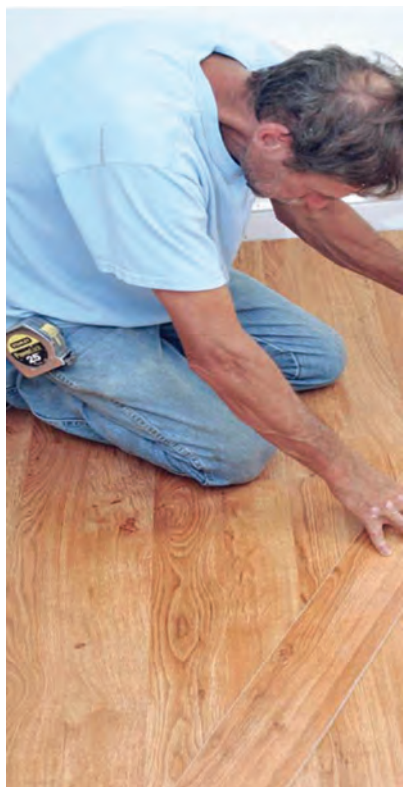
سمت چپ: نصب قطعات لمینت، سمت راست: نصب آخرین قطعات لمینت در جوار قرنیز موجود
