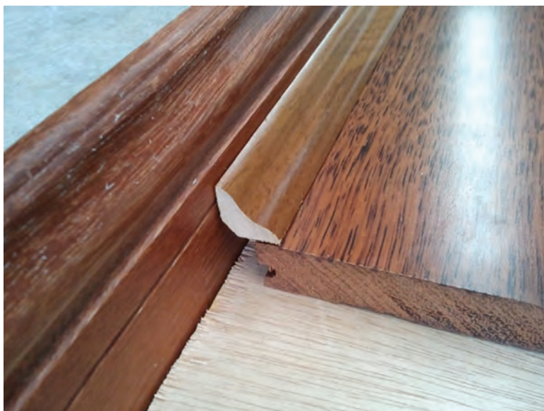
استفاده از ابزار اسکوتیا برای اتصال کف پوش به قرنیز
