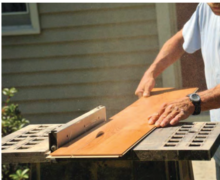
برش طولی قطعات لمینت در فضای باز برای کاهش گرد و غبار
