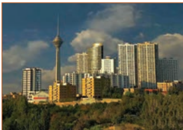
الف - ساختمان سازی
