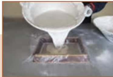
ث - ریختن ملات گچ در قالب
