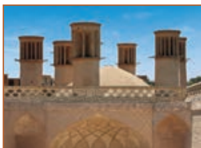
الف- استفاده از آجر در ساختمان‌های قدیمی
