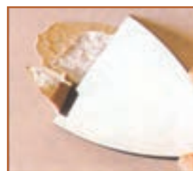
الف - باز کردن ترک‌ها
