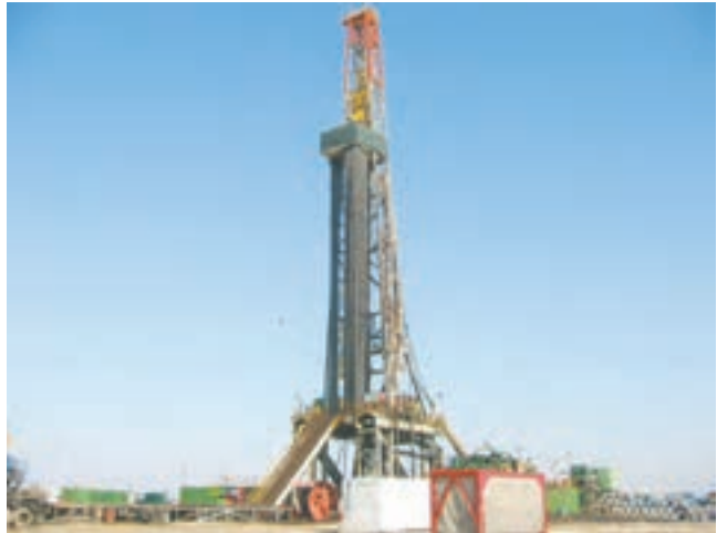
شکل ۱۰- دکل حفاری چاه‌های اکتشافی نفت و گاز
